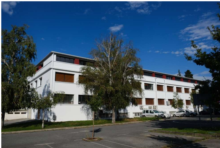
Fachada lateral Oeste
