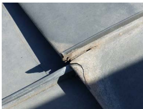
Chapa de zinc de cubierta agujereada y con roturas en pliegues. Chimenea de caldera
