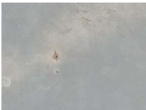
Chapa de zinc de cubierta agujereada y con roturas en pliegues. Chimenea de caldera
