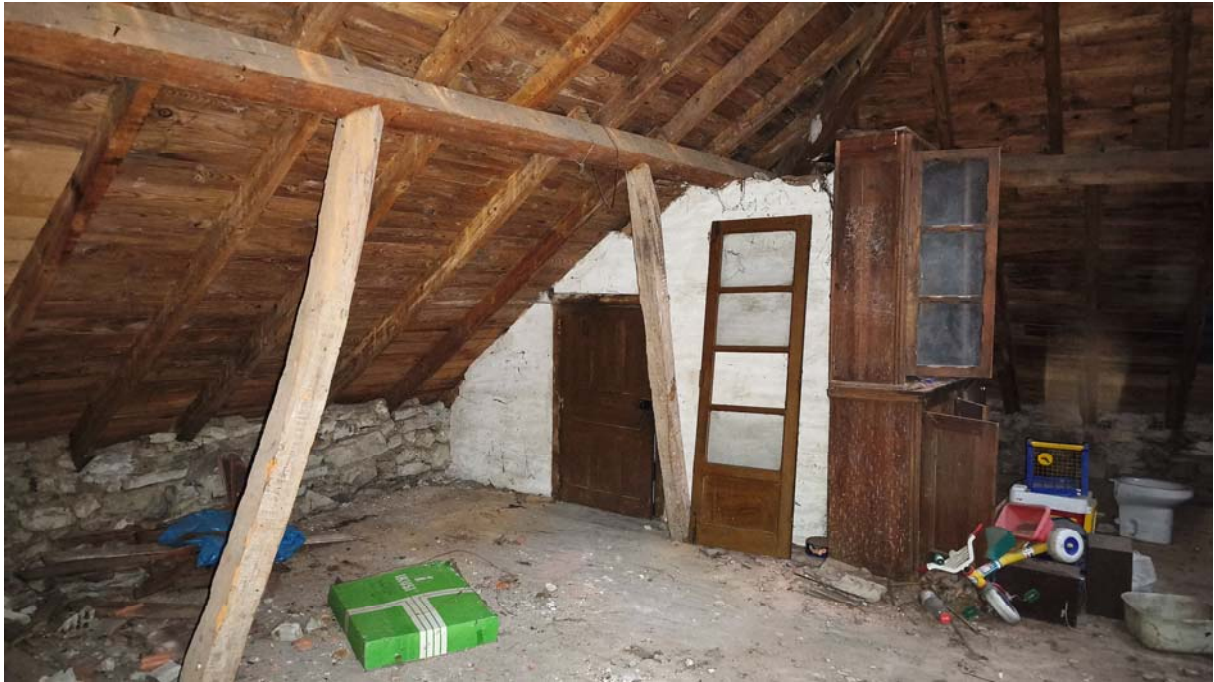
ACCESO DESDE ESCALERAS
