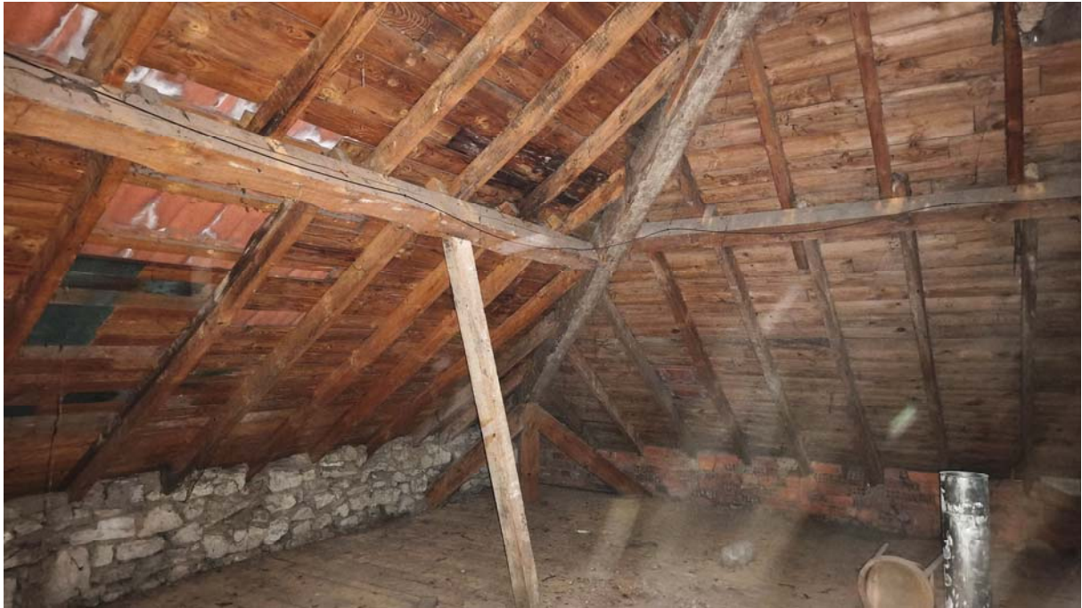
ESQUINA CON COLINDANTE CON EDIFICIO CONTIGUO
