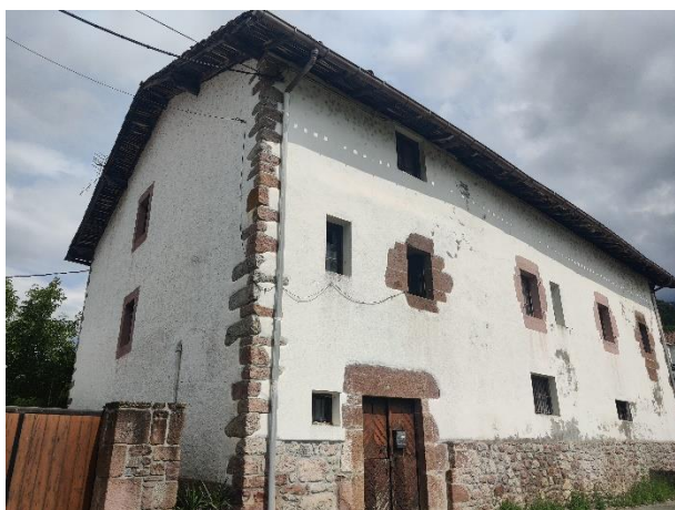
Fig 2.5 Fachadas oeste y norte
