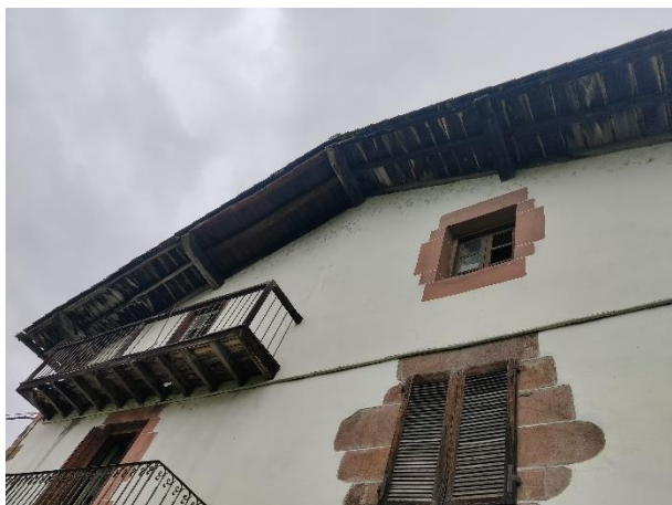
Fig 2.7 Vista de la fachada principal
