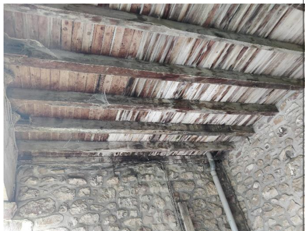
Fig 2.8 Forjado zaguán exterior
