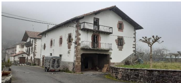
Fig 2.3 Fachadas sur (principal) y oeste
