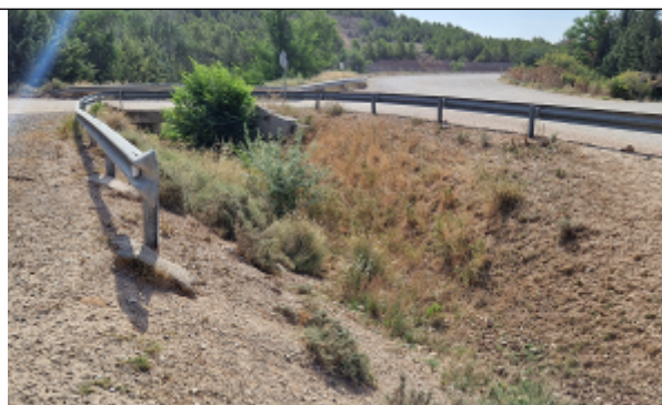
Imagen 2_Vista aguas arriba del puente
