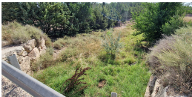
Imagen 4_Vista aguas abajo desde el puente, se aprecian las aletas hechas con piedra de escollera
