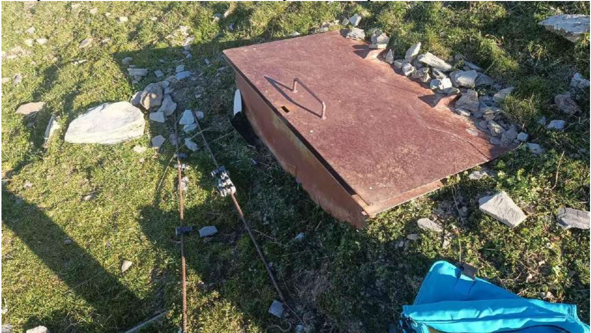
Foto 6: Arqueta a sustituir
