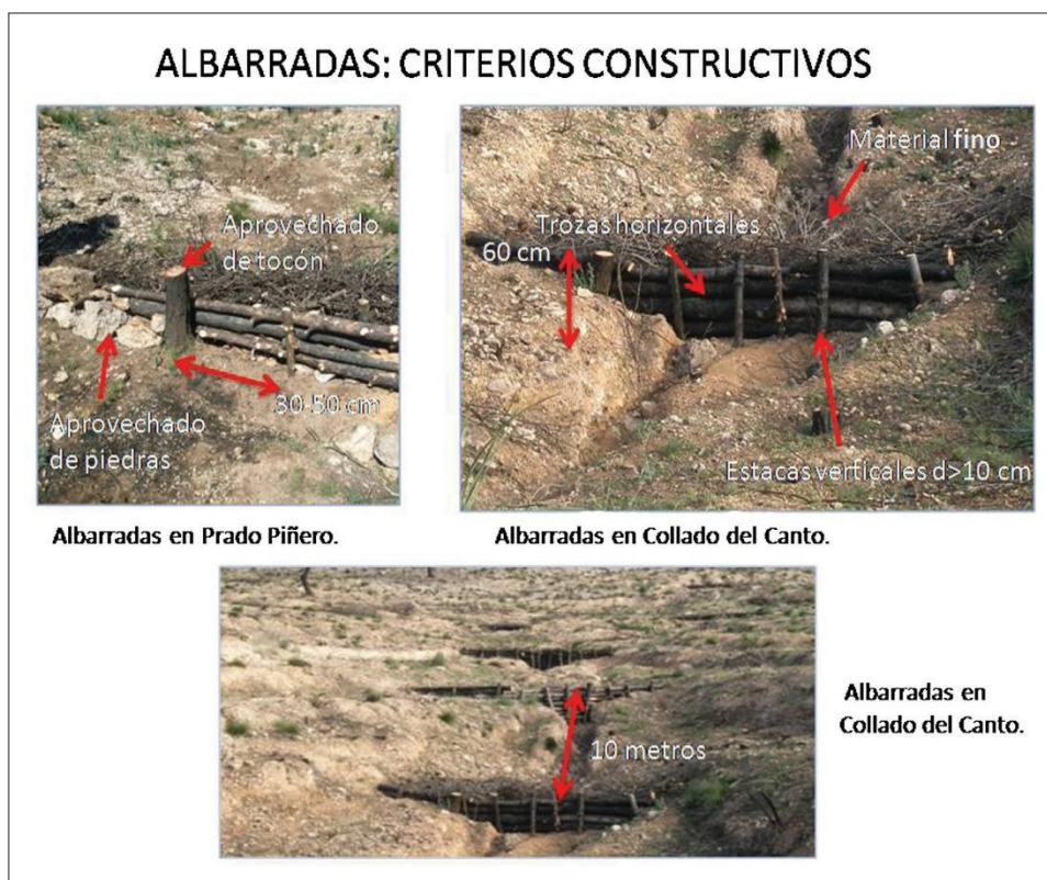
Foto 1 Albarradas. Criterios constructivos (d=diámetro estacas).
