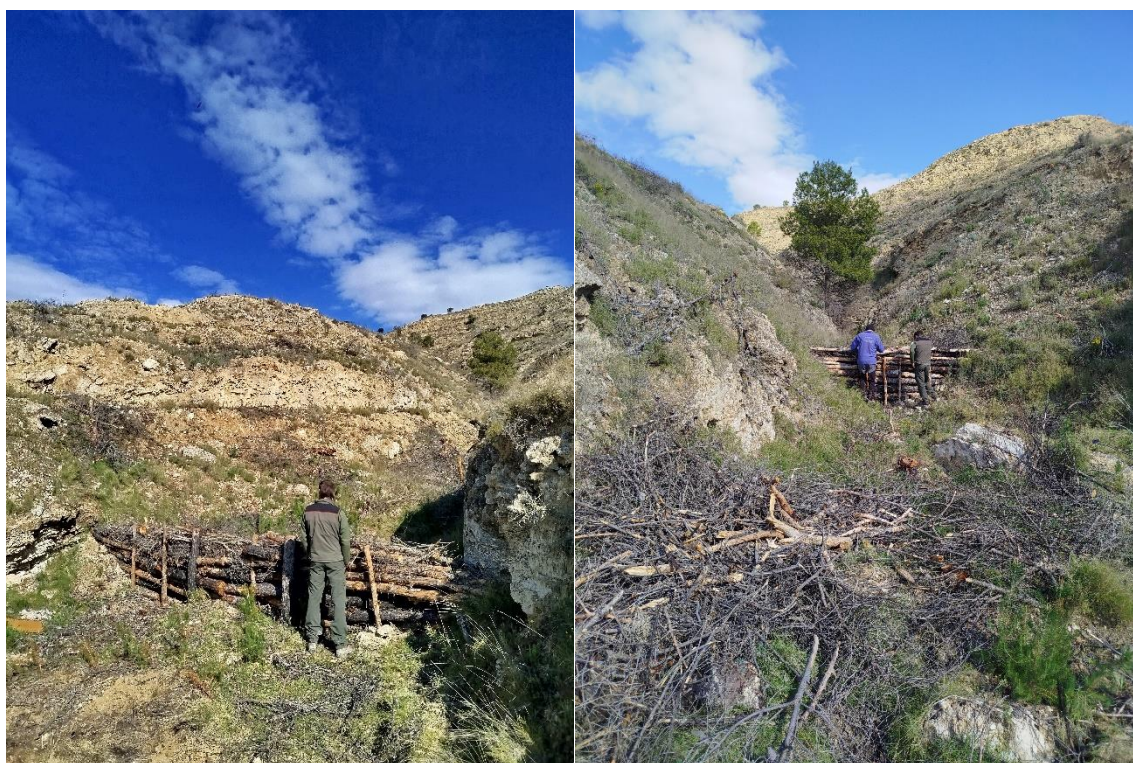
Foto 2 Ejemplo de albarradas realizadas a modo de ensayo en el ámbito de actuación del proyecto
