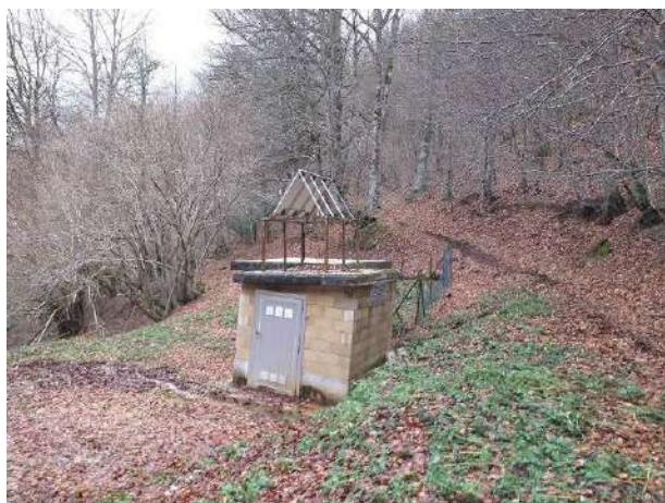
Figura 2: Caseta de toma Iturriotz
