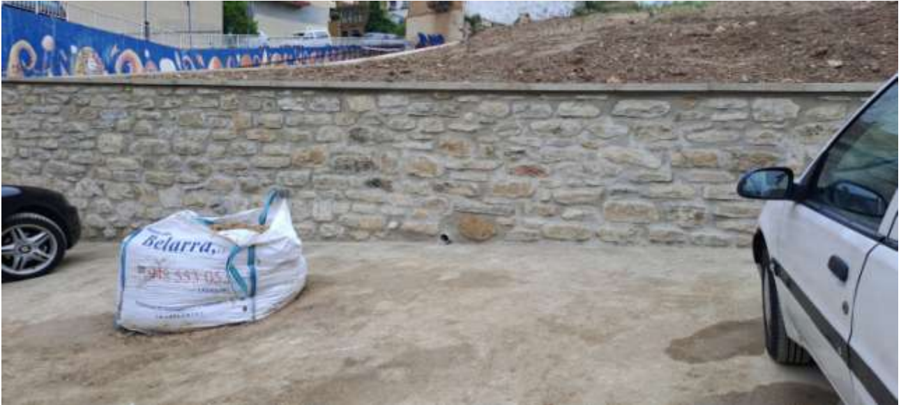
Muro a proteger con un seto disuasorio
