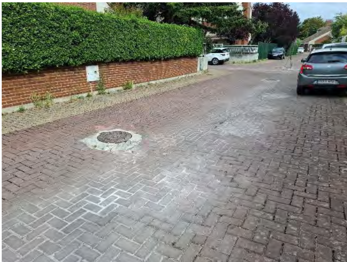
Encintados de hormigón fracturados, pavimentos hundidos. Se observan las zonas con charcos.
