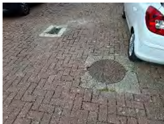
Encintados de hormigón fracturados, pavimentos hundidos. Se observan las zonas con charcos.
