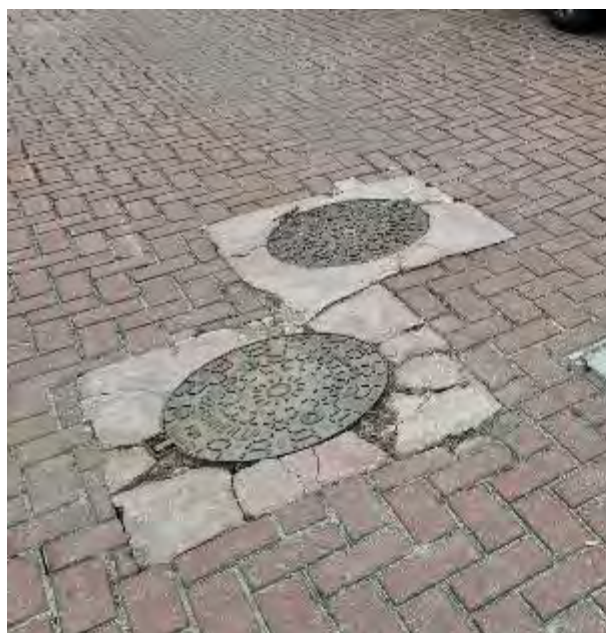
Encintados de hormigón fracturados, pavimentos hundidos. Se observan las zonas con charcos.
