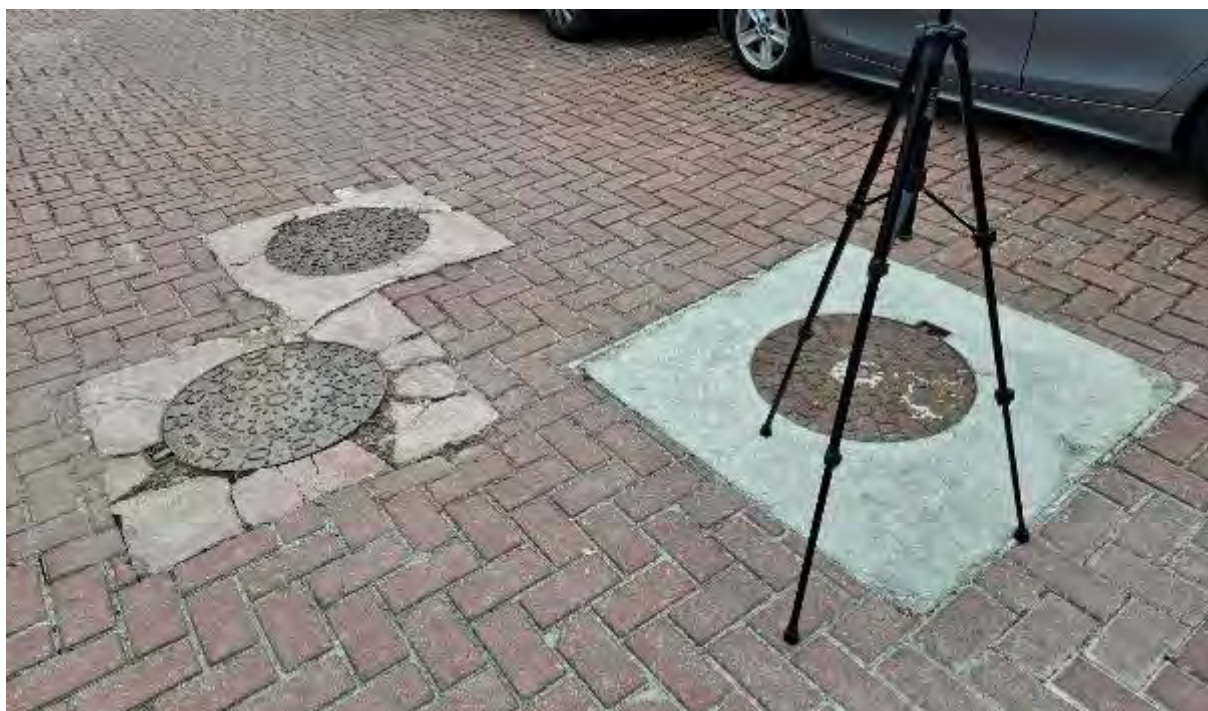
Recerco reparado recientemente junto a otros muy dañados en ejes de calle.
