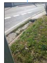
cuneta/caz longitudinal superficial existente
