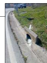
punto de vertido existente a caz longitudinal
