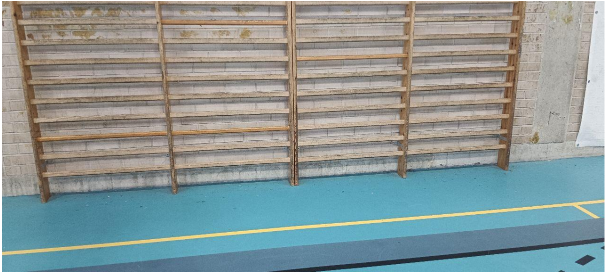
Imagen de espalderas y detalle de anclaje
