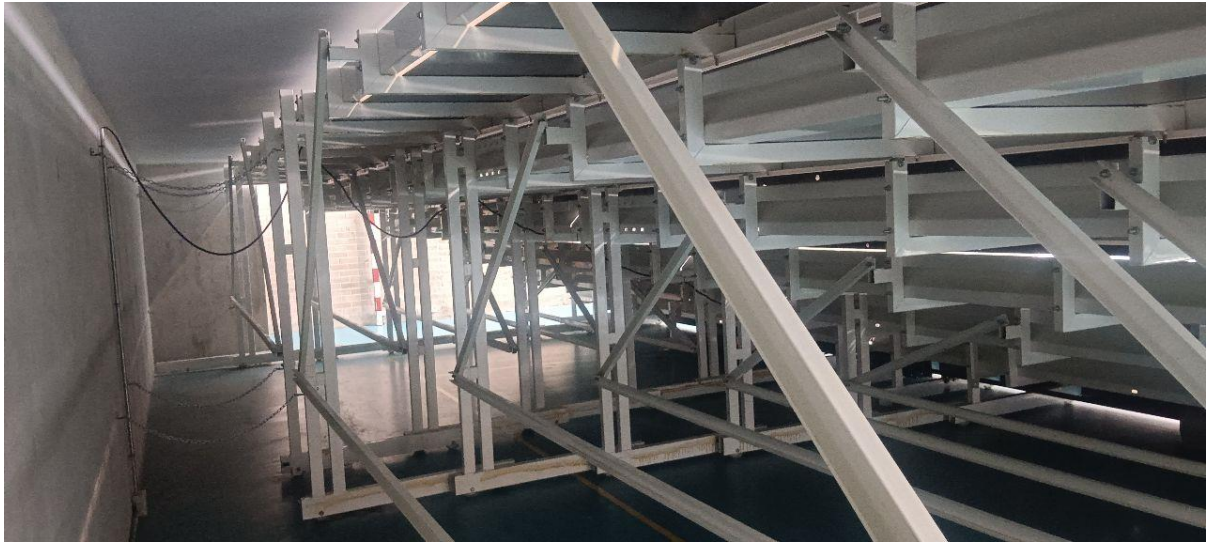
Fotografías del espacio a pavimentar con las gradas completamente desplegadas.
