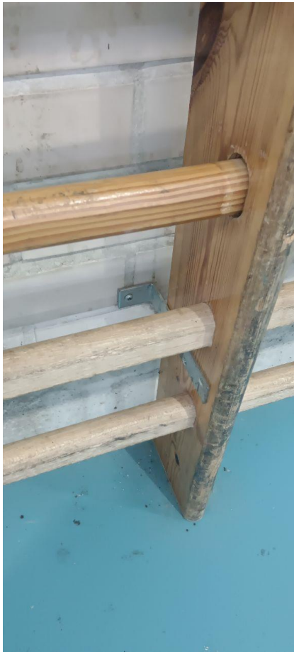
Imagen de espalderas detalle de anclaje
