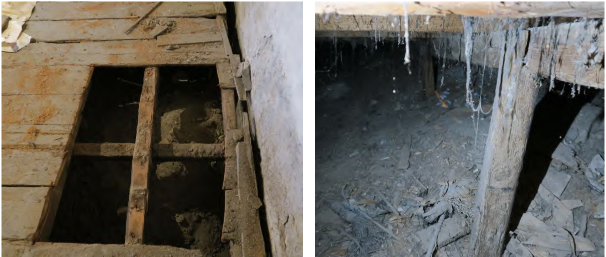
Cata realizada en el piso del sobre coro a través de la cual se puede observar el sistema de entramado de madera y puntales apoyados en la bóveda
