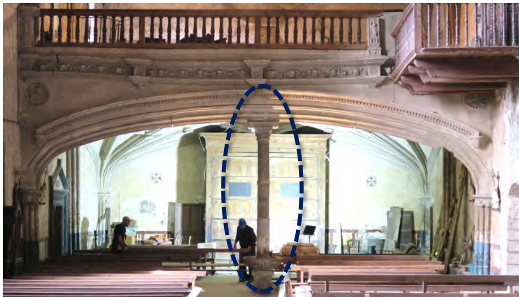
Vista frontal del coro desde la nave con la columna de piedra apeando la clave del arco
