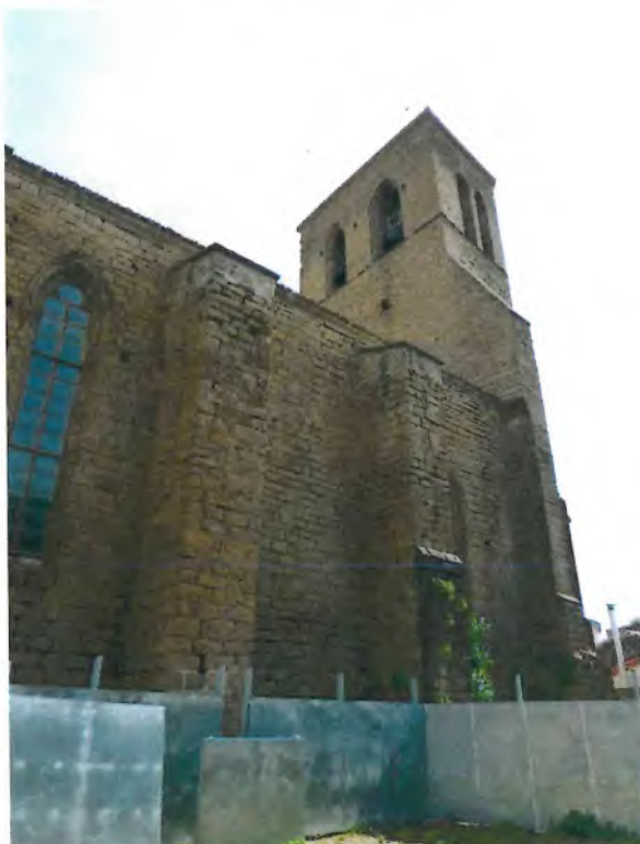
Figura 1: Fachada sur de la iglesia
