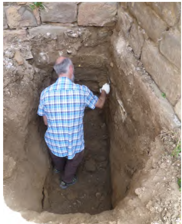
Fotografías de la cimentación de uno de los estribos tomadas durante la realización de catas de reconocimiento en 2014
