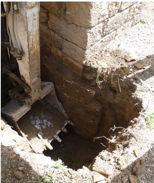
Fotografías de la cimentación de uno de los estribos tomadas durante la realización de catas de reconocimiento en 2014
