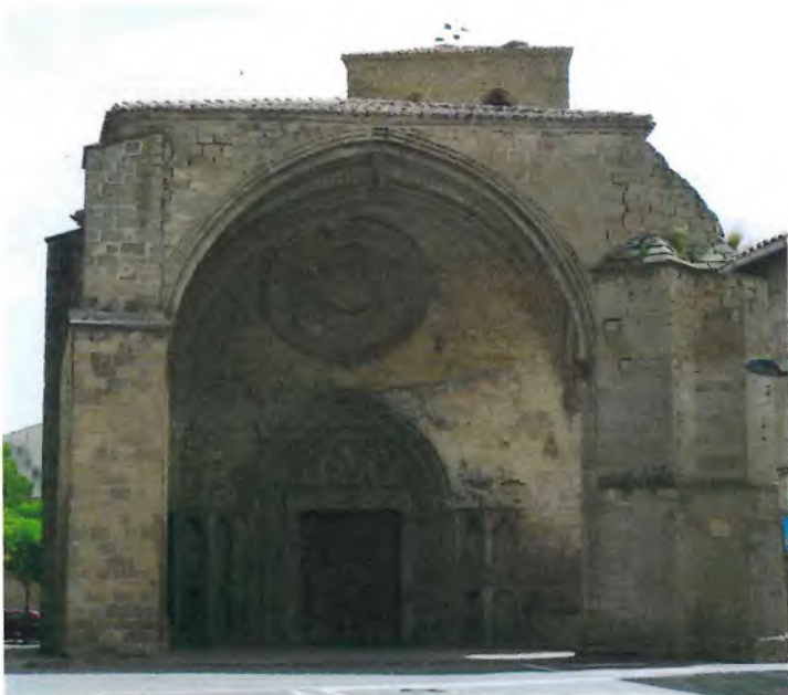
Fotografía 1: Vista oeste de la iglesia
