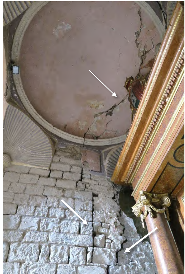
Estado actual del cerramiento oeste y la cúpula
