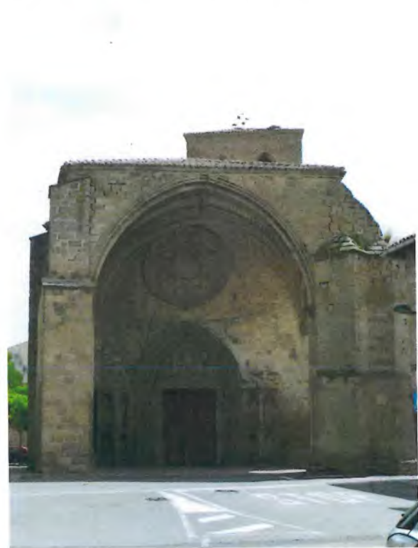
Figura 2: Fachada oeste de la iglesia
