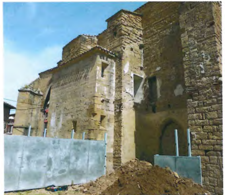
Fotografía 2: Vista sur de la iglesia
