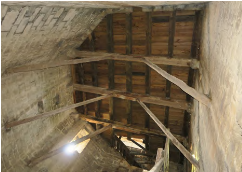
Estado actual del interior de la torre. Izquierda: forjado intermedio. Derecha: estructura de cubierta
