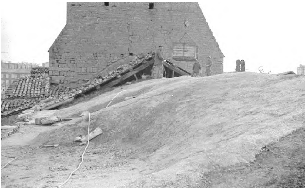
Fotografía tomada durante la obra de cambio de cubierta y encamisado de las bóvedas con hormigón armado
