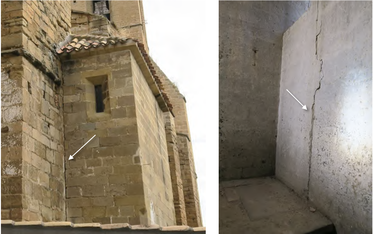
Separación entre el volumen de la escalera y el estribo sur de la nave al que se adosa. Izquierda: vista por el exterior. Derecha: vista por el interior.
