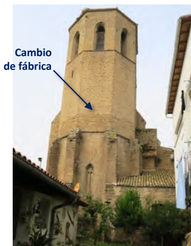
Fotografías del estado actual de la torre levantada sobre los parapetos que remataban la construcción del ábside.
