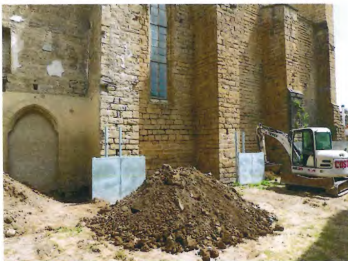
Fotografía 3: Fachada sur de la iglesia
