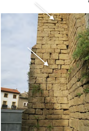
Grietas en los estribos y separación entre la fábrica del muro y el estribo (imagen derecha)
