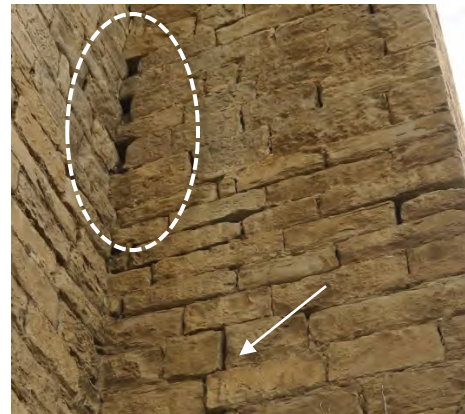
Grietas en los estribos y separación entre la fábrica del muro y el estribo (imagen derecha)
