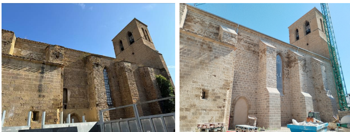
Alzado sur del edificio, antes y después de la primera fase de la restauración
