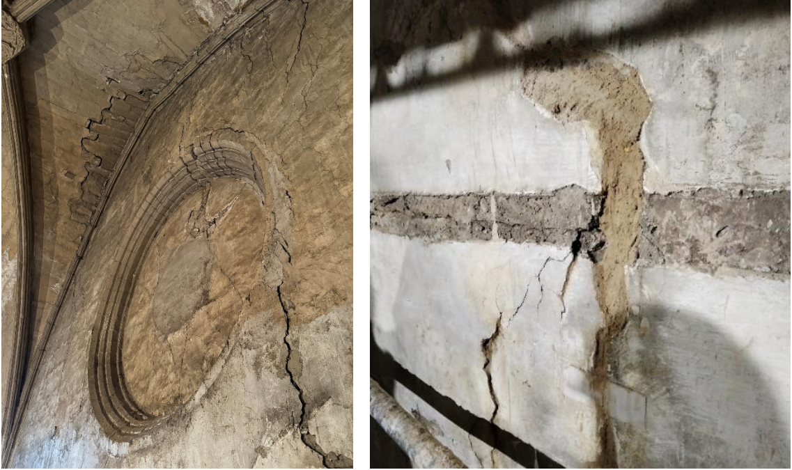
Sellado de las grietas del muro de los pies, antes y después
