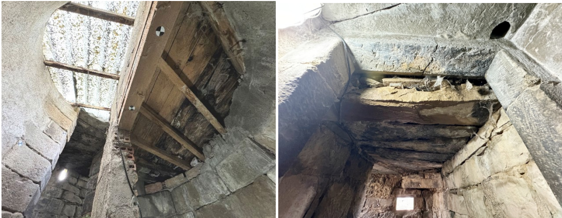
Vistas interiores de la cubierta de la escalera de caracol y de la cubierta de losa de piedra que cubre el tránsito de comunicación entre la escalera caracol y la torre
