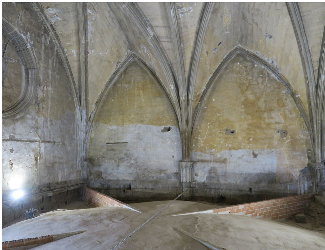
Trasdós de la bóveda del coro e intradós de las bóvedas de los tramos de los pies de la nave
