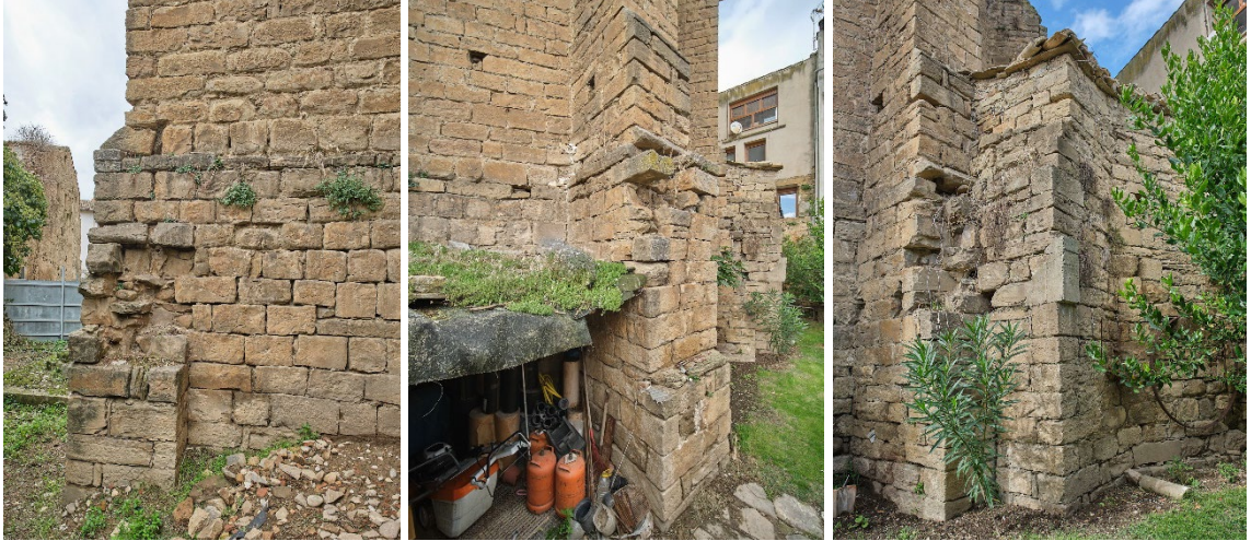
Arranque de los contrafuertes de la torre
