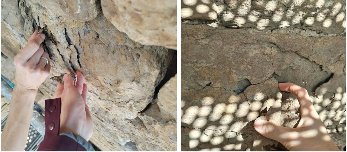
Ejemplos de sillares erosionados y con deplacaciones
