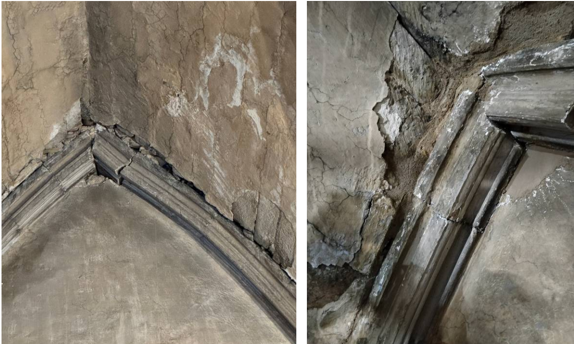
Sellado de las grietas de las bóvedas de los dos tramos de los pies de la nave, en el encuentro entre la plementería y los nervios de los muros laterales, antes y después
