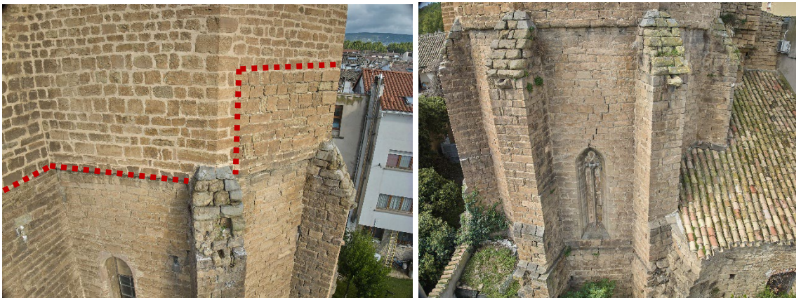
Fachada este de la torre, arriba, antes y después de la restauración de 1998. Abajo a la izquierda se ha grafiado el límite de la actuación
