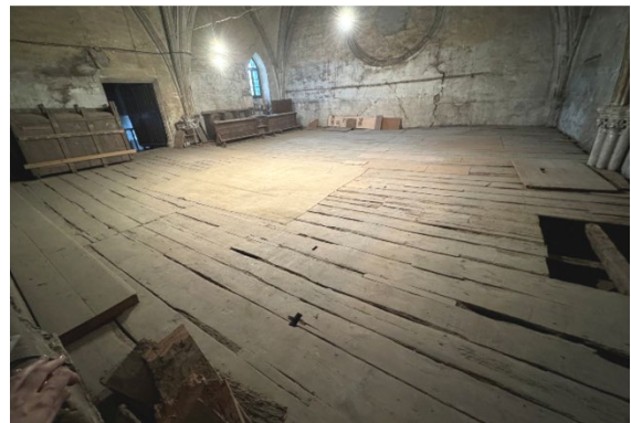
5 de noviembre de 2024. Retirada de acopios
