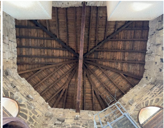
Cubierta de la torre. Estructura
