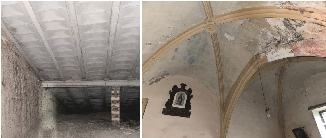
Espacio bajocubierta y bóvedas de la sacristía
