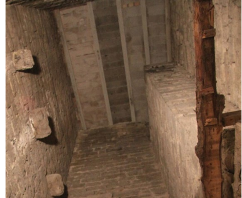
Torreón. Estructura de cubierta
