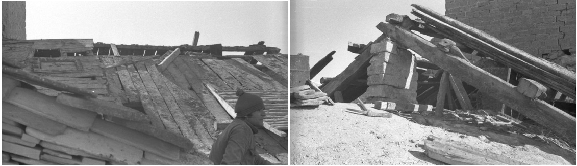
Año 1978. Obras de rehabilitación de la cubierta. Desmontando la anterior cubierta
