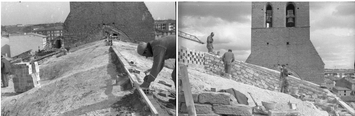
Año 1978. Rehabilitación de la cubierta. Formación de pendientes con tabiques conejeros
