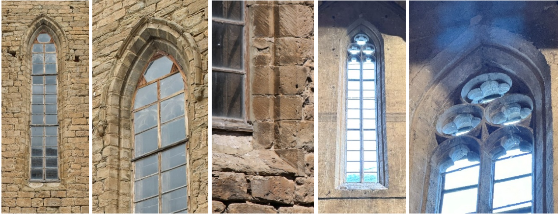
Ventanal tramo 3. Exterior e interior
