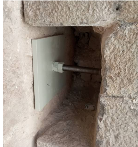
Arriba, vista del coro durante el desmontado de la subestructura del entablado del pavimento y del trasdós de la bóveda limpio con los tirantes colocados. Abajo, detalle de dos de las placas de retención en el muro sur
