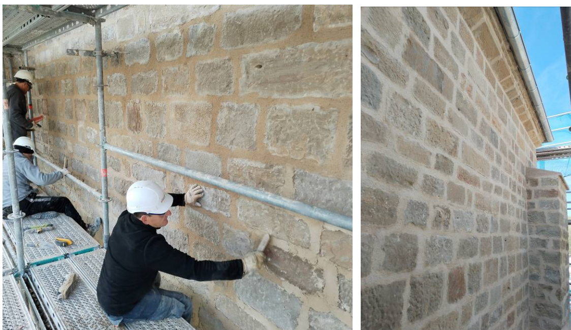
Proceso de cepillado del rejuntado y estado de las fábricas una vez finalizados los trabajos
