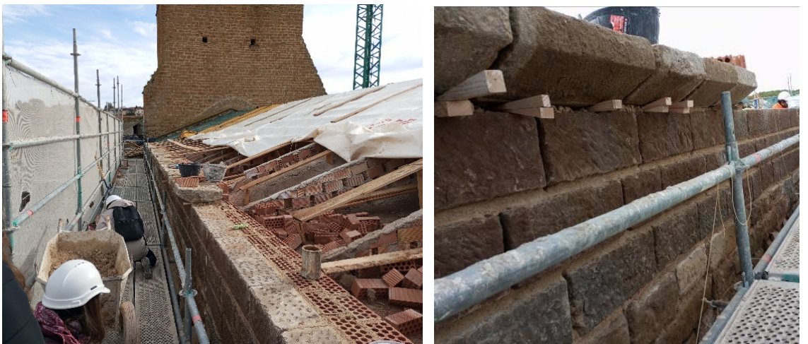
Proceso de ejecución del recrado del muro de coronación, recolocando la cornisa existente
