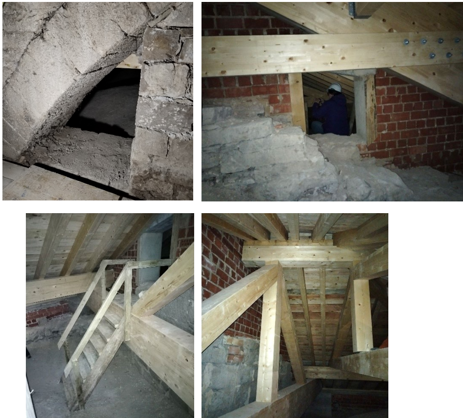
Arriba, huecos de acceso y de conexión entre bajocubiertas. Abajo, bajocubierta del atrio
