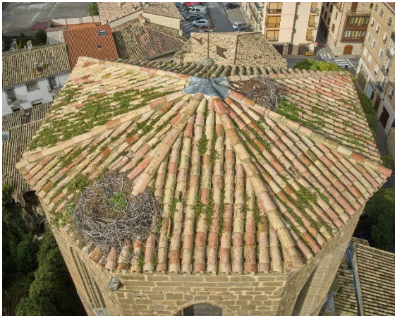
Cubierta de la torre
