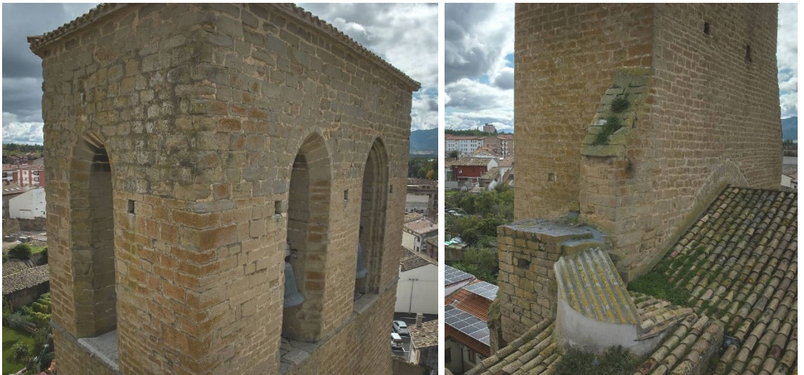
Fachadas norte y oeste de la torre
