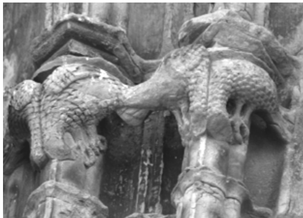
Detalle de la ventana del tramo pies
