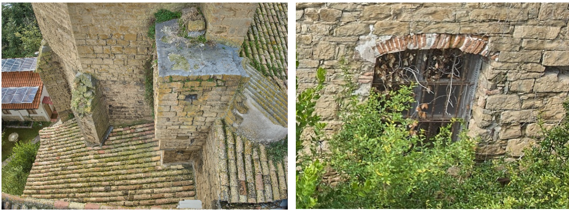
Cubierta y ventana de la sacristía
