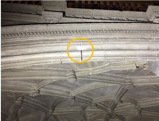
28 de octubre de 2024. Testigos de yeso Arco del coro
