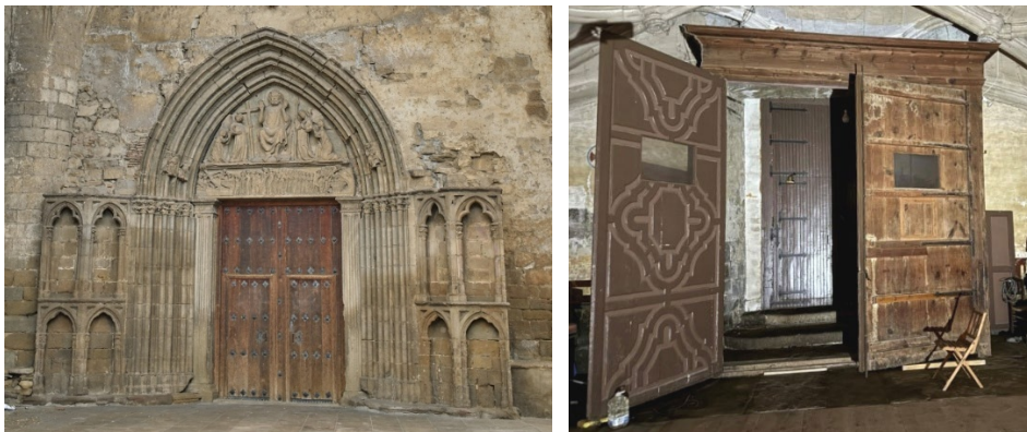
Puerta principal. Exterior, interior y cancel
