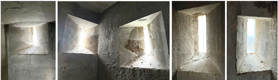
Vanos de la escalera de subida al coro
