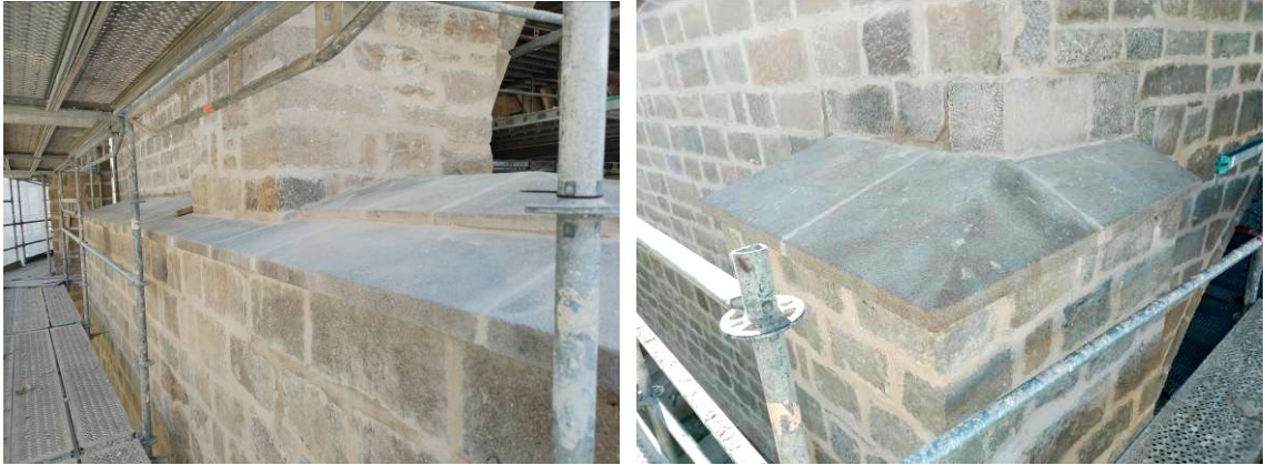
Detalle de los nuevos remates con sillares trapezoidales en el muro norte del atrio
