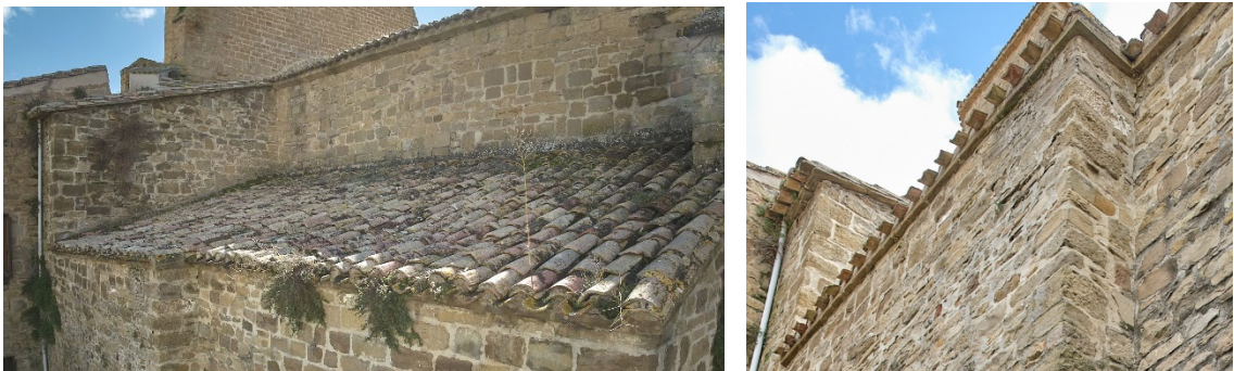
Capillas de la Conversión de San Pablo y de San Sebastián. Detalle de la cubierta y el alero
