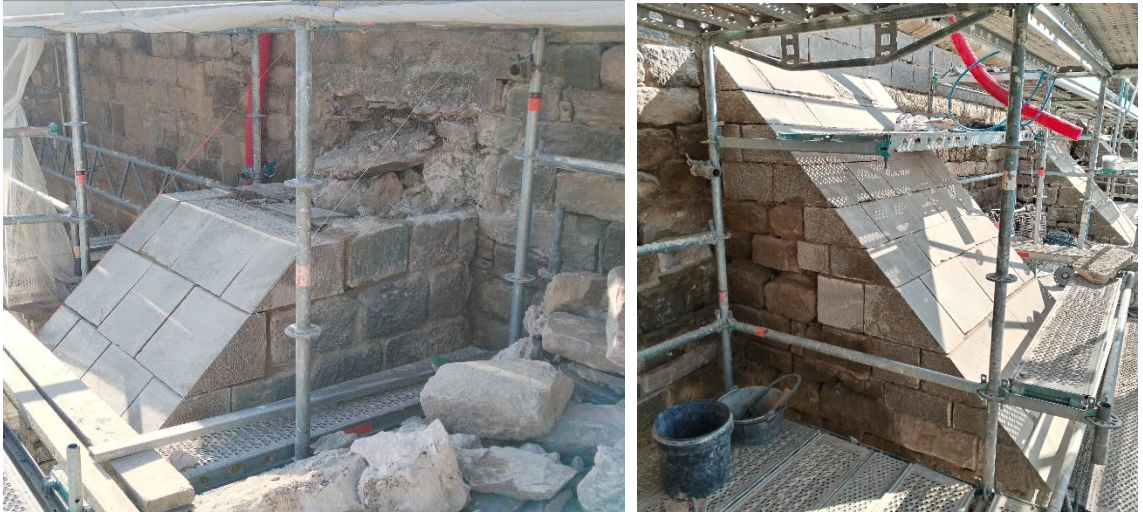
Arriba, remate de los contrafuertes antes del inicio de las obras y durante el desmontado. Abajo, ejecución de los nuevos derrames
