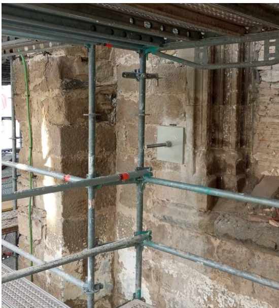
Arriba, vista del coro durante el desmontado de la subestructura del entablado del pavimento y del trasdós de la bóveda limpio con los tirantes colocados. Abajo, detalle de dos de las placas de retención en el muro sur
