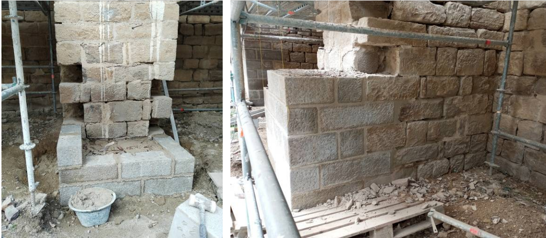
Proceso de ejecución del recrecido de los contrafuertes de la fachada sur
