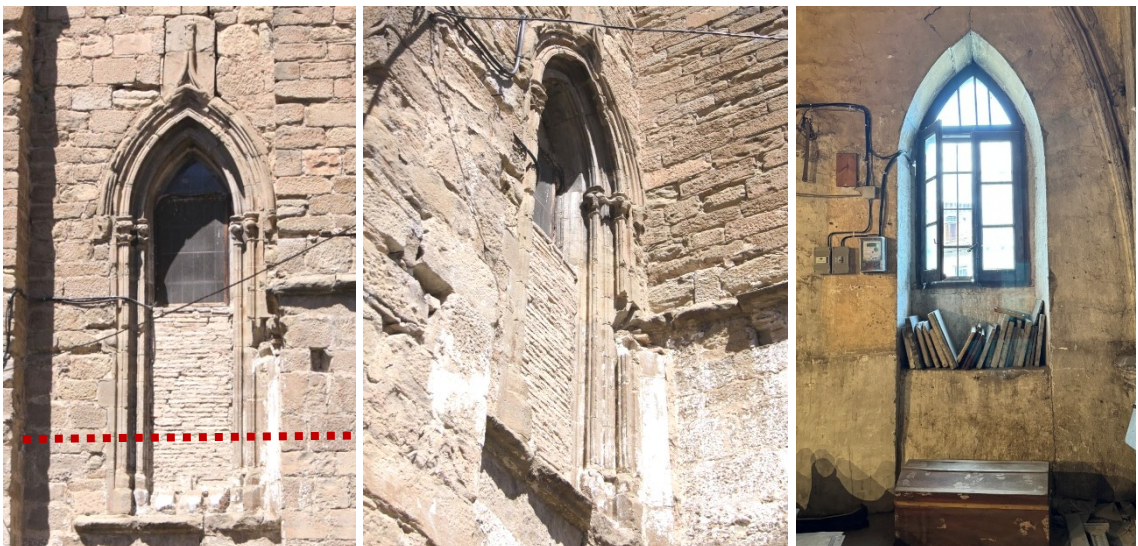
Ventanal tramo 6 (coro). Exterior e interior ■■■ Nivel del coro
