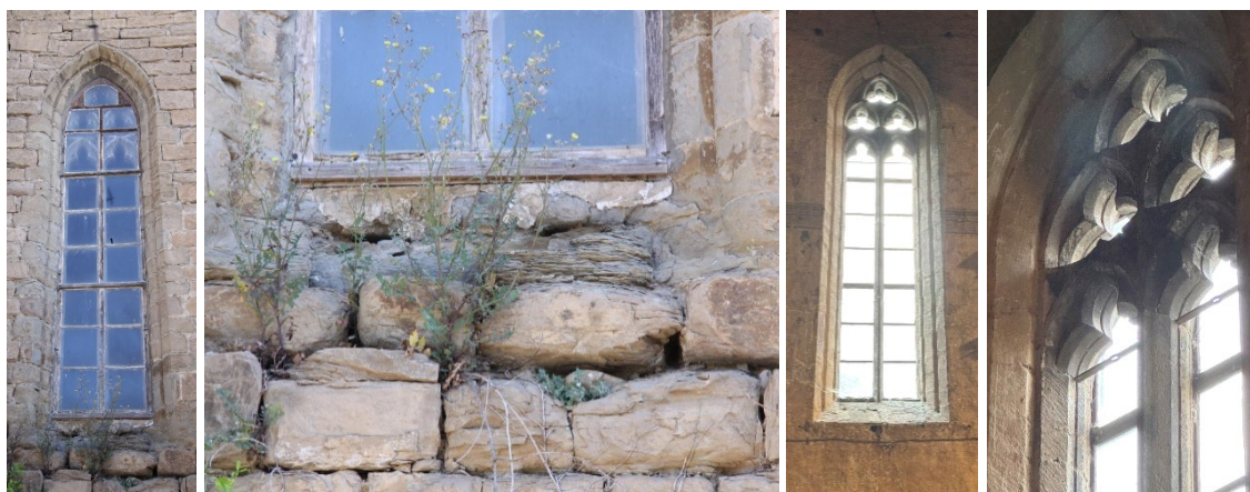
Ventana tramo 1. Exterior e interior
