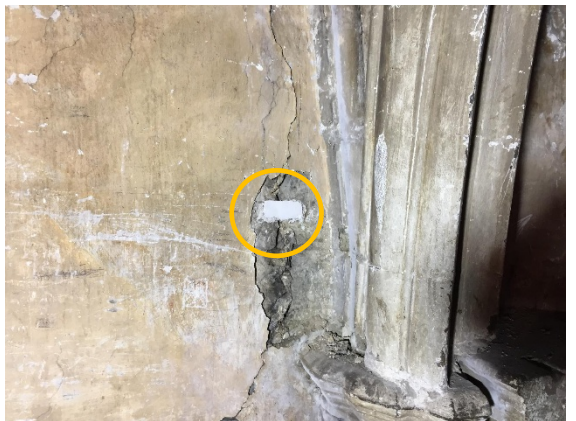
29 de octubre de 2024. Testigos de yeso Lado septentrional entre tramos 5 y 6 Fuente: Rogelio Taboada
