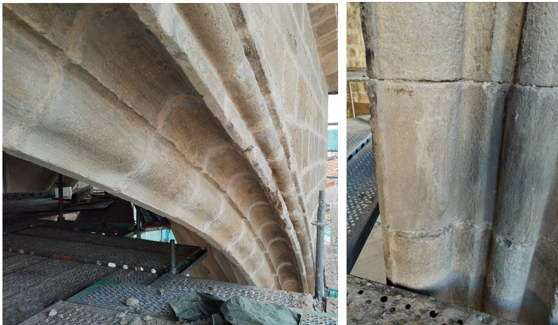
Detalle de los sillares moldurados que conforman el arco occidental del atrio y sus pilastras una vez consolidados y sellados los fragmentos con riesgo de revestimiento y las fisuras
