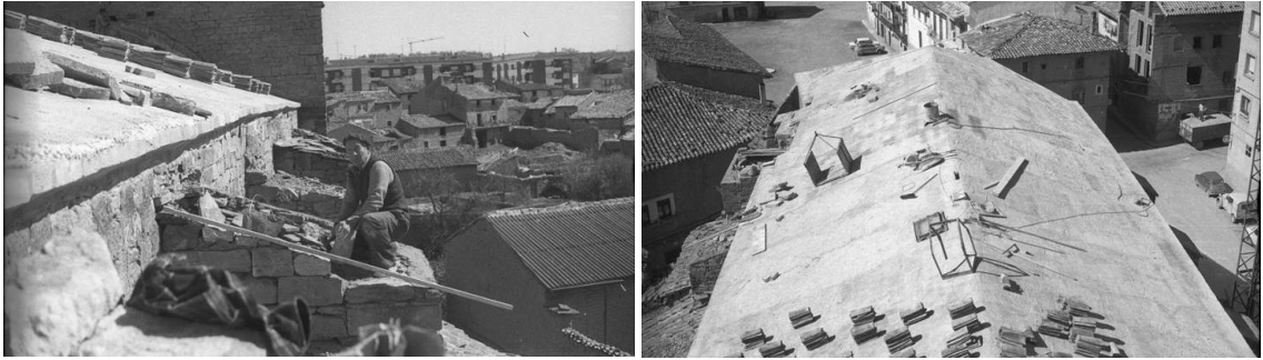
Año 1978. Rehabilitación de la cubierta Trabajos en las tapas de contrafuertes. Cubrición con teja cerámica árabe
