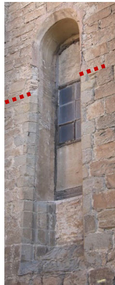
Ventanal sur del ábside. Exterior e interior ■■■■ Nivel de arranque de ojiva
