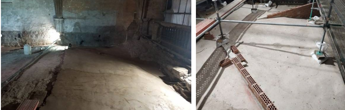
Trasdós de la bóveda del coro, durante el extendido del mortero de cal y una vez ejecutadas las costillas
