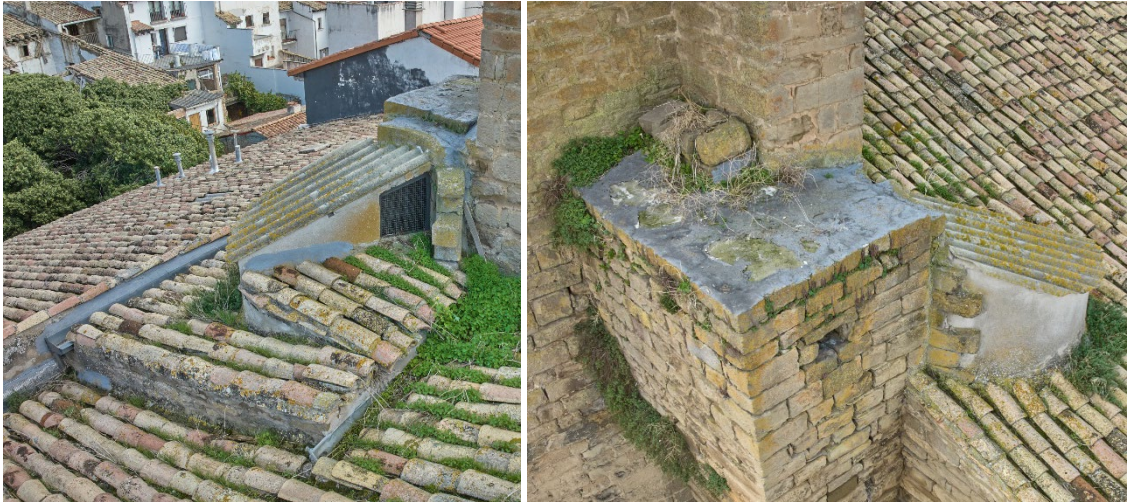
Cubierta de escalera de caracol de acceso a torre. Interior y exterior
