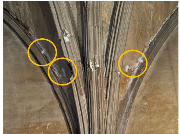
29 de octubre de 2024. Testigos de yeso Lado septentrional entre tramos 5 y 6
