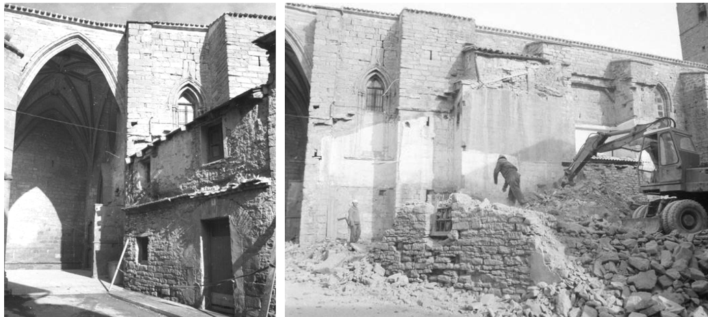
Años 80. San Salvador y su entorno. Derribando las edificaciones adosadas al sur ya han sido derribadas Fuente: Fondo Beunza. Grupo Cultural Enrique II de Albret
