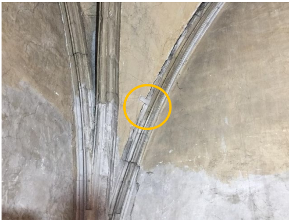
29 de octubre de 2024. Testigos de yeso Lado septentrional tramo 6
