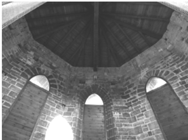
Vista del exterior y el interior de la torre, arriba y abajo respectivamente
