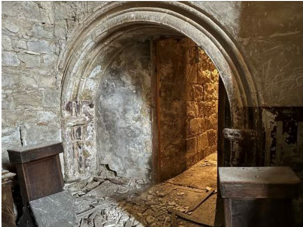
Capilla de la Conversión de San Pablo. Filtraciones desde la bajante de pluviales y presencia de humedad y sales
