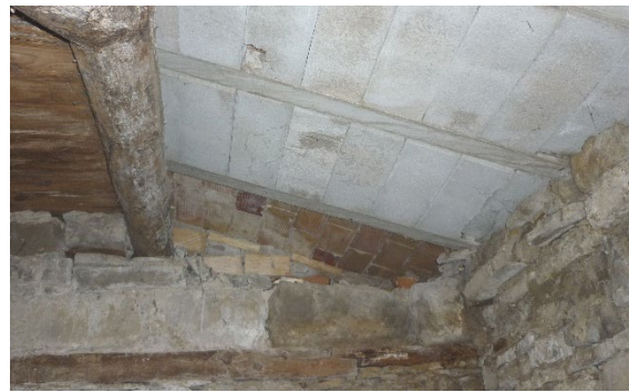
2013. Capilla de la Conversión de San Pablo Bajocubierta. Estructura de cubierta y sobrepiso
