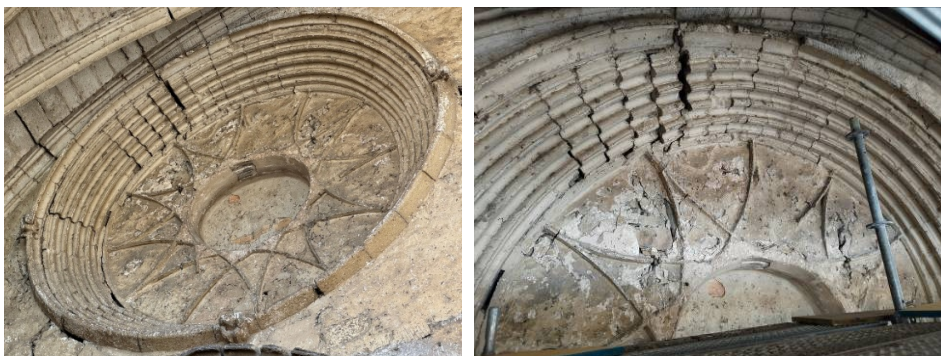
Rosetón de los pies. Exterior (atrio) e interior (coro). Detalle de la tracería al interior
