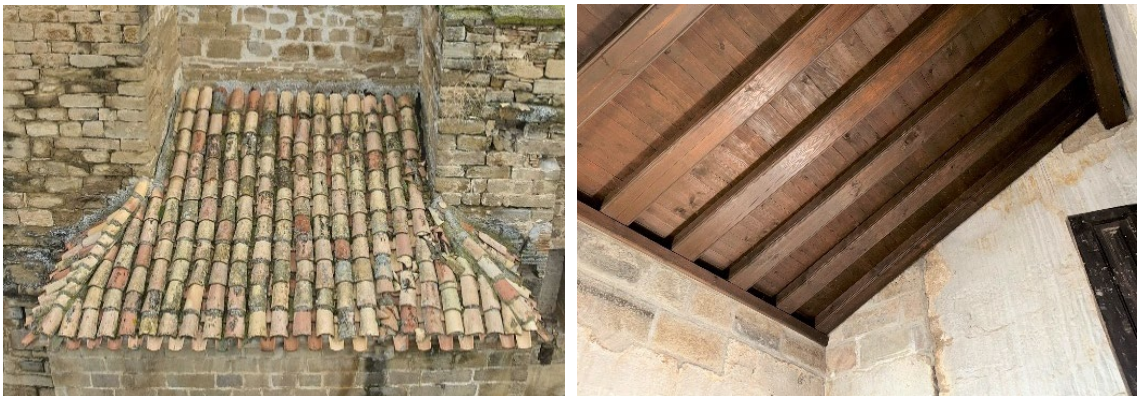
Cobertura y estructura de la cubierta de la escalera de acceso al coro
