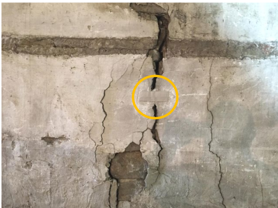
29 de octubre de 2024. Testigos de yeso Lado septentrional tramo 6 Fuente: Rogelio Taboada
