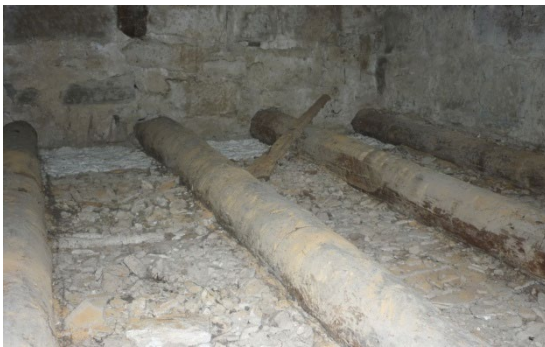
2013. Capilla de la Conversión de San Pablo Bajocubierta. Estructura del cielo-raso
