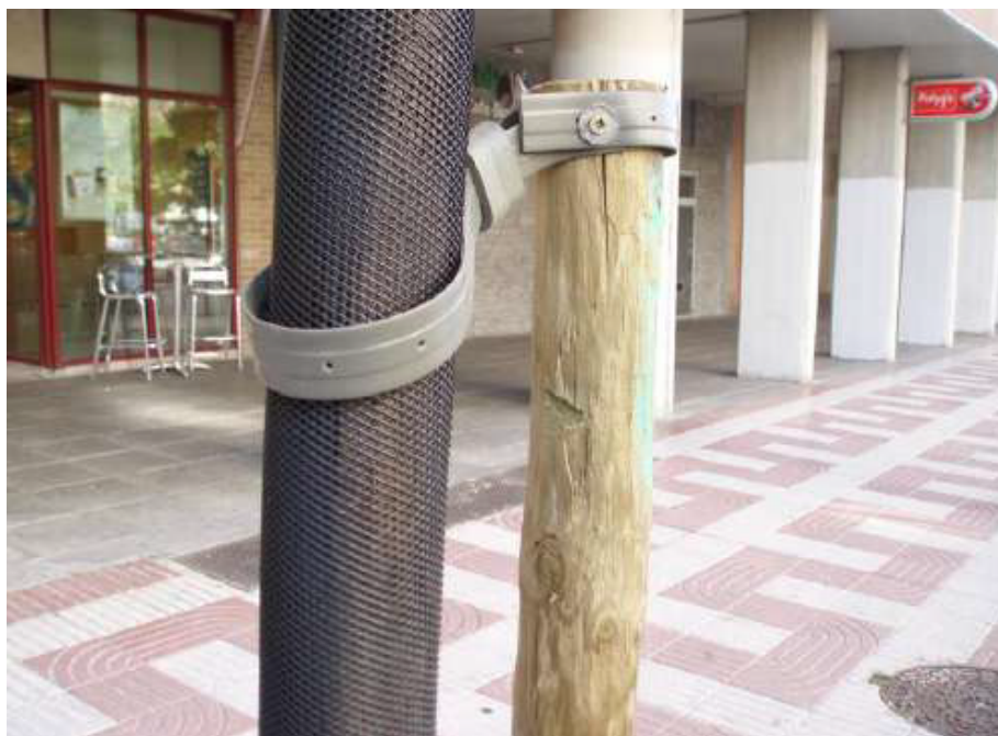
Colocación adecuada de tutor y malla antifendas. Fuente: Plan de infraestructura verde de Ansoáin.
