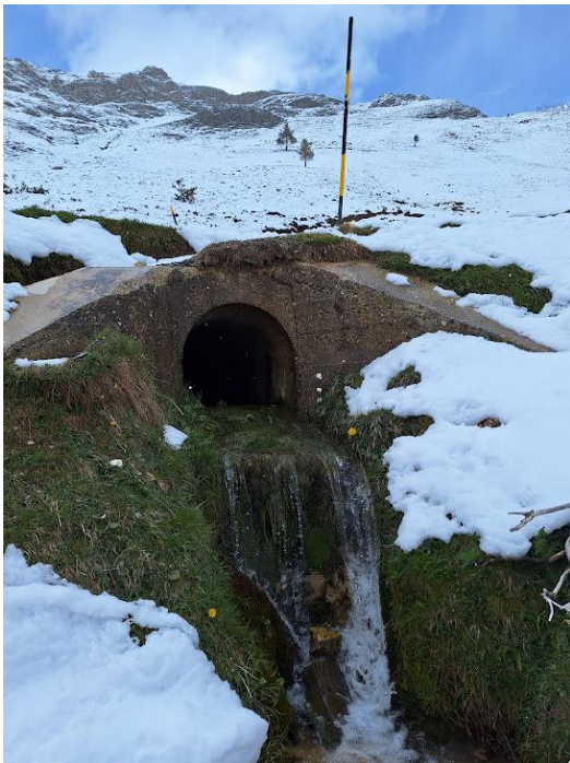
Dren transversal de la carretera contiguo al área de trabajo.
