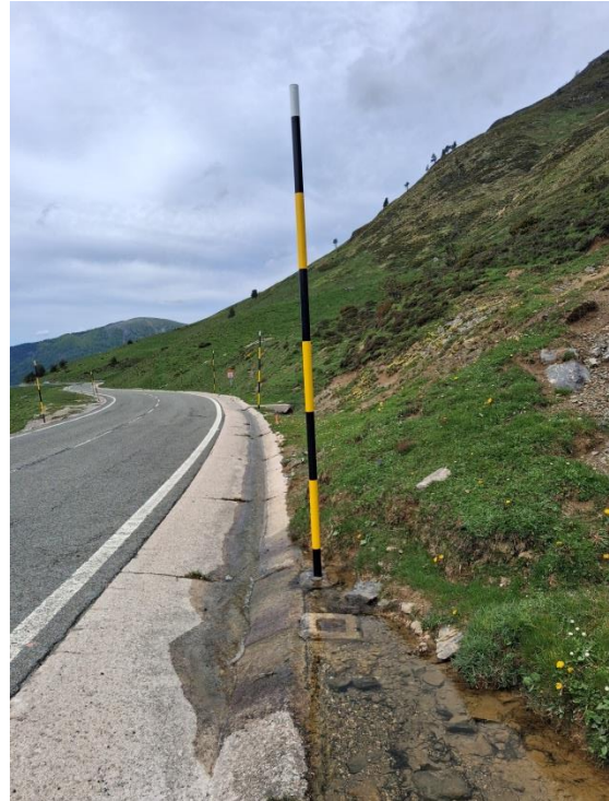
Perspectiva desde tramo contiguo superior. El hito deberá ser retirado para el paso de la tubería y, posteriormente, recolocado.
