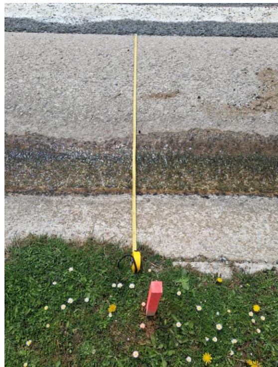
Cuneta a restituir.-
