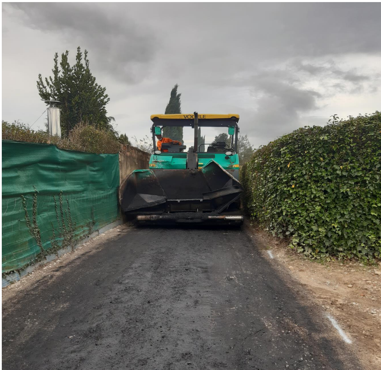
Extendidora de asfalto
