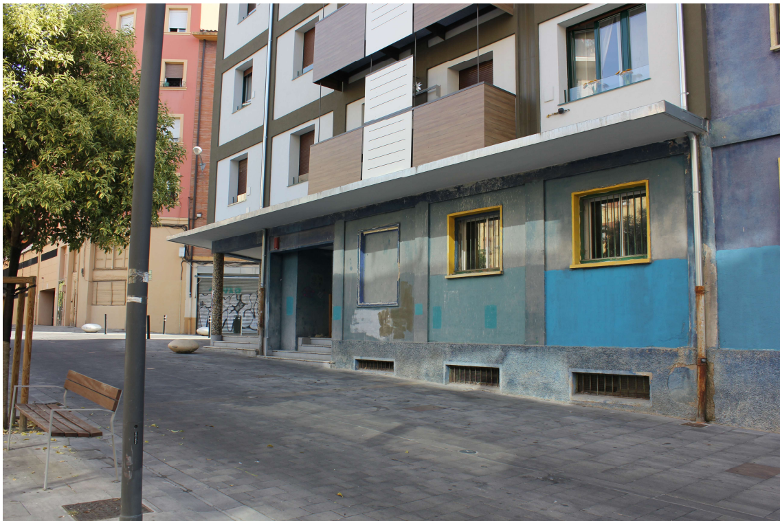
VISTA ZONA DE ENTRADA ANTIGUA Y ACTUAL DESDE LA CALLE MANUEL DE FALLA
