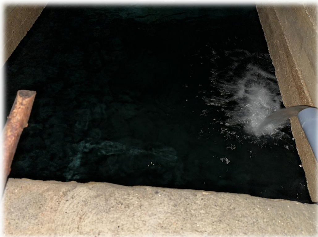
Fotografía 3 – Vista de la entrada de agua al único vaso existente.
