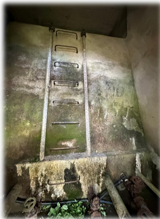
Fotografía 2 – Vista del alzado de la subida a los vasos, valvulería a retirar.
