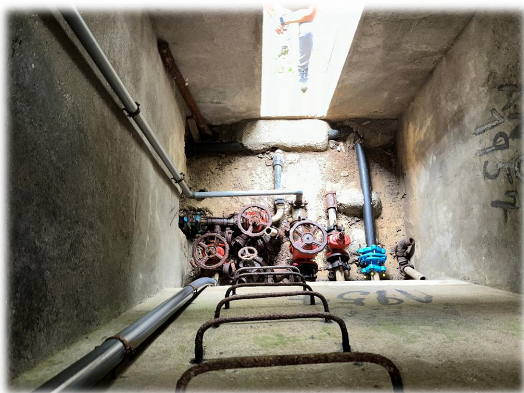
Fotografía 4 – Vista desde arriba valvulería a cambiar.
