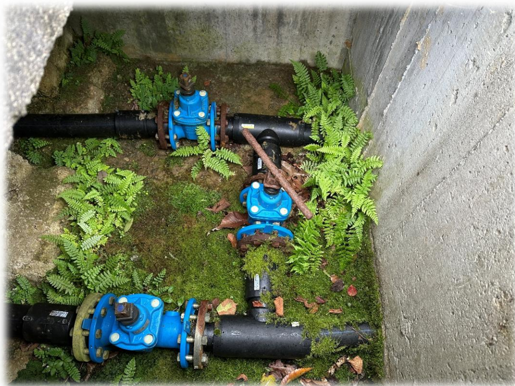
Fotografía 2 – Arqueta by.pass existente.
