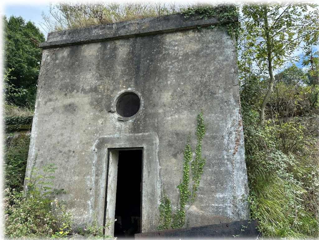
Fotografía 1 – Vista exterior de la cámara del depósito.
