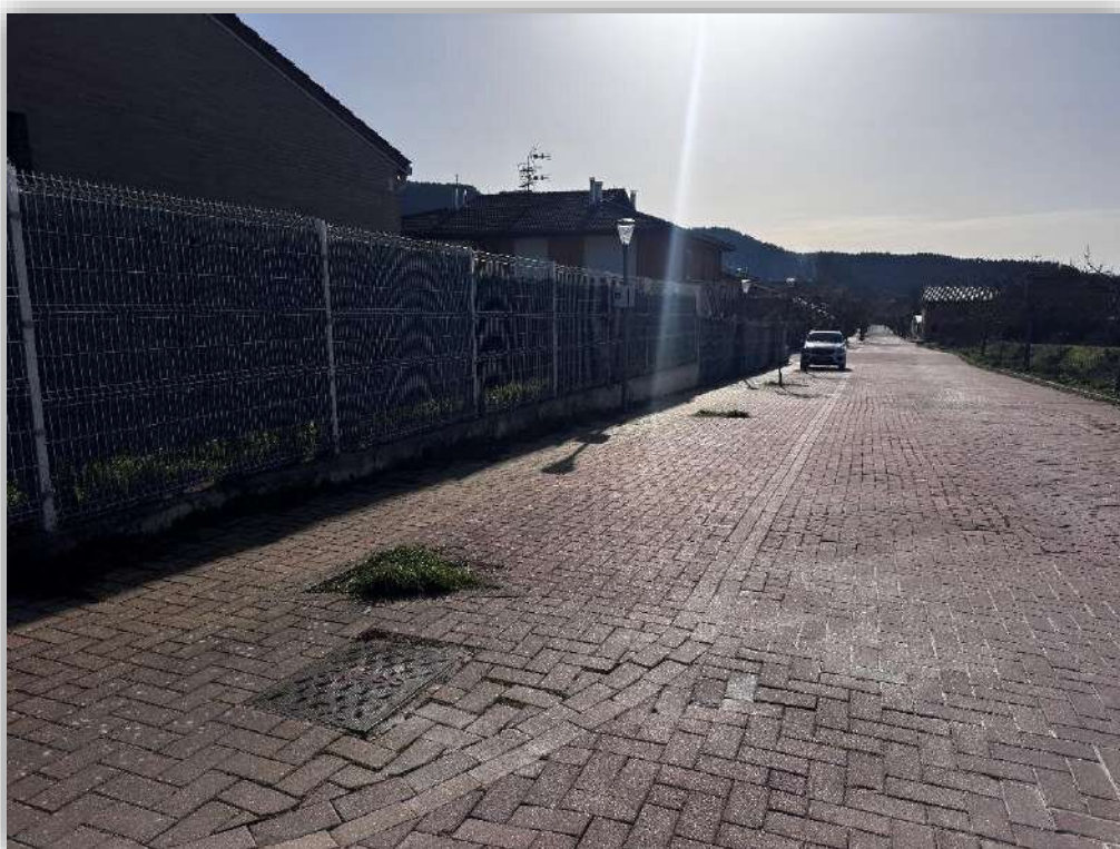
Fotografía 2 – Vista general estado actual
