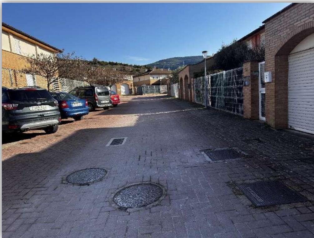
Fotografía 9 – Vista general estado actual.
