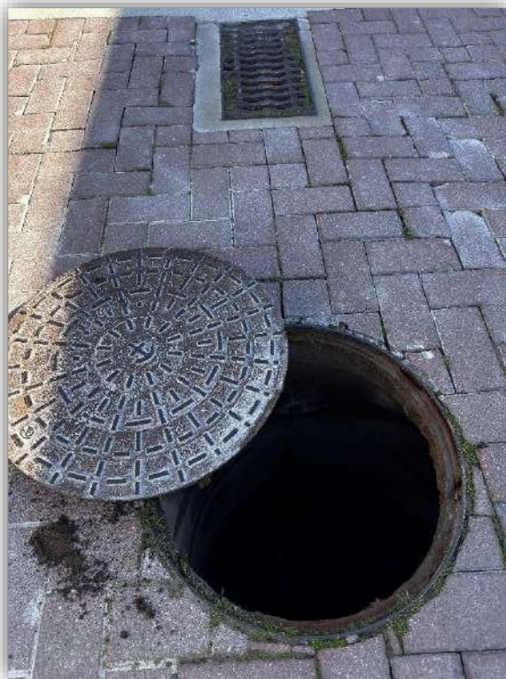
Fotografía 15 – Conexión de sumidero a pozo existente
