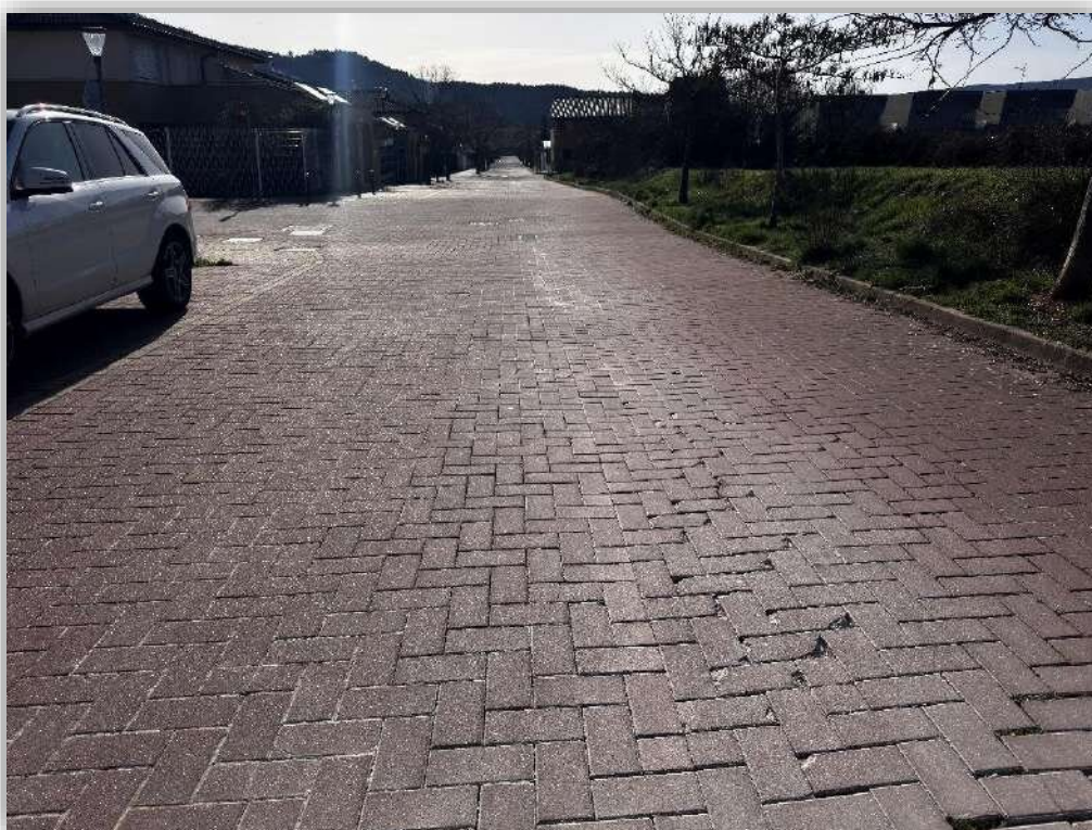
Fotografía 4 – Vista general estado actual
