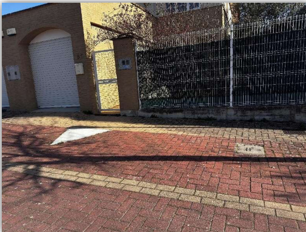
Fotografía 5 – Vista general estado actual. Adoquín de separación entre calzada y acera
