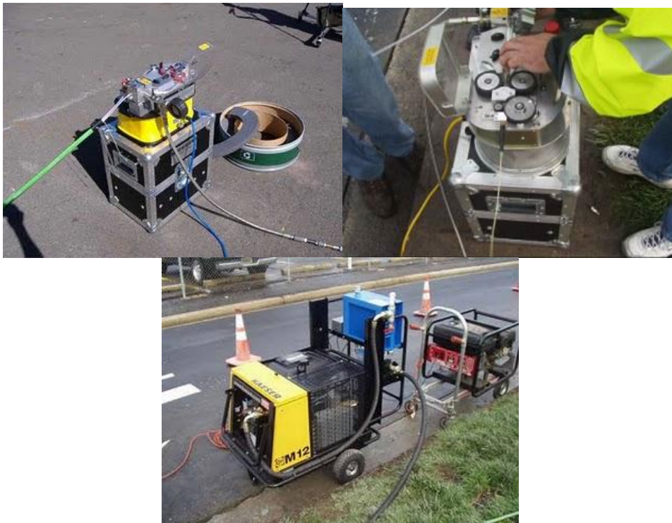
Figura 18. Proceso de soplado de la fibra óptica.
