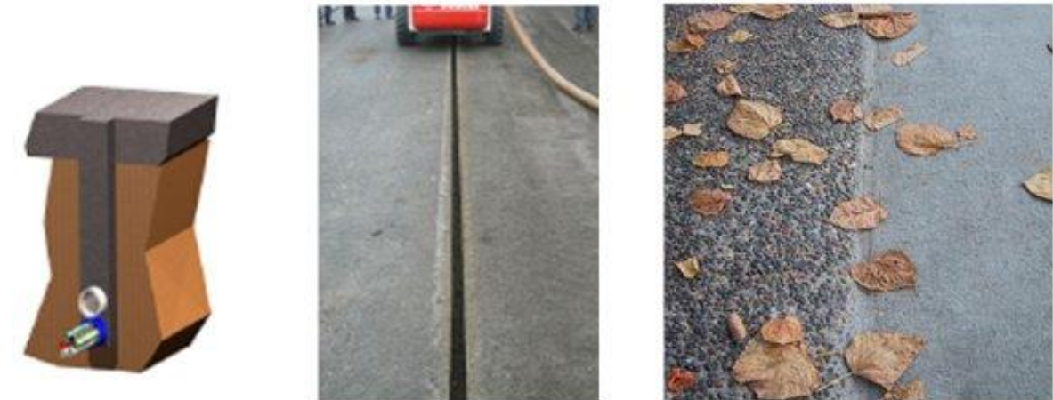
a) Esquema de instalación de cable en microzanjas; b) realización de una microzanja; c) aspecto final tras proceso de rellenado
