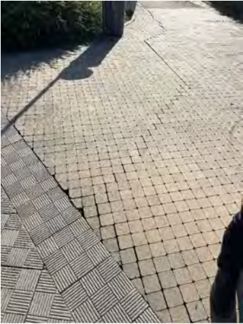
FOTO 22: Rotura de piezas en el encuentro entre pavimentos
