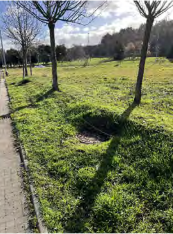
FOTO 23: Partes del riego automático que han quedado al descubierto
