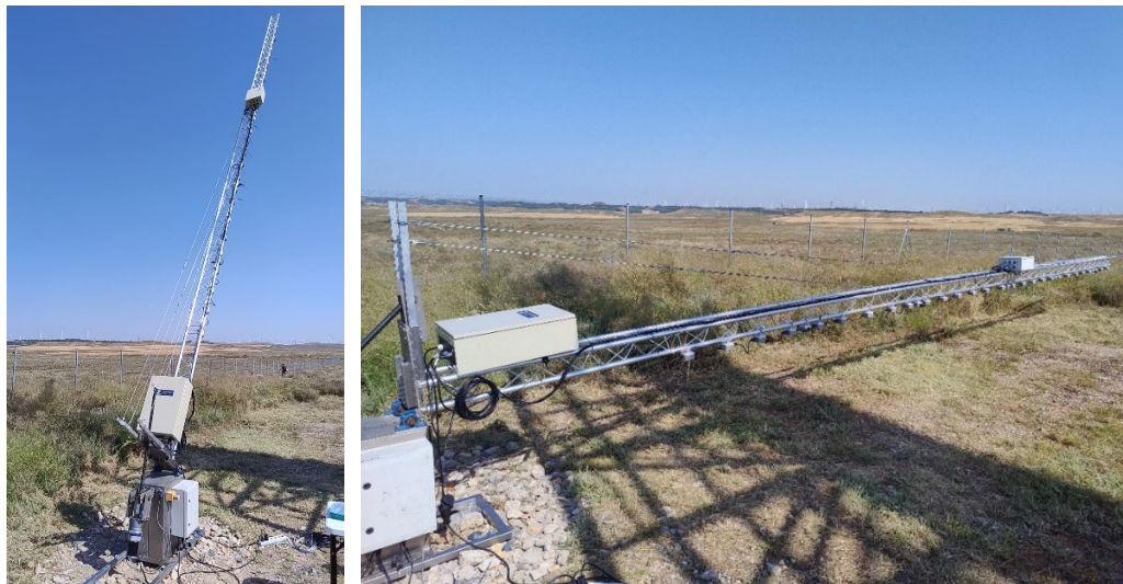
Figura 2. Mástil con sistema de izado actual
