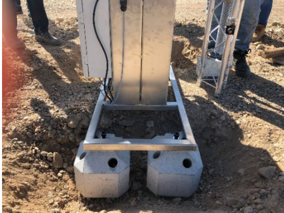
Figura 3. Cimentación basada en pilodres
