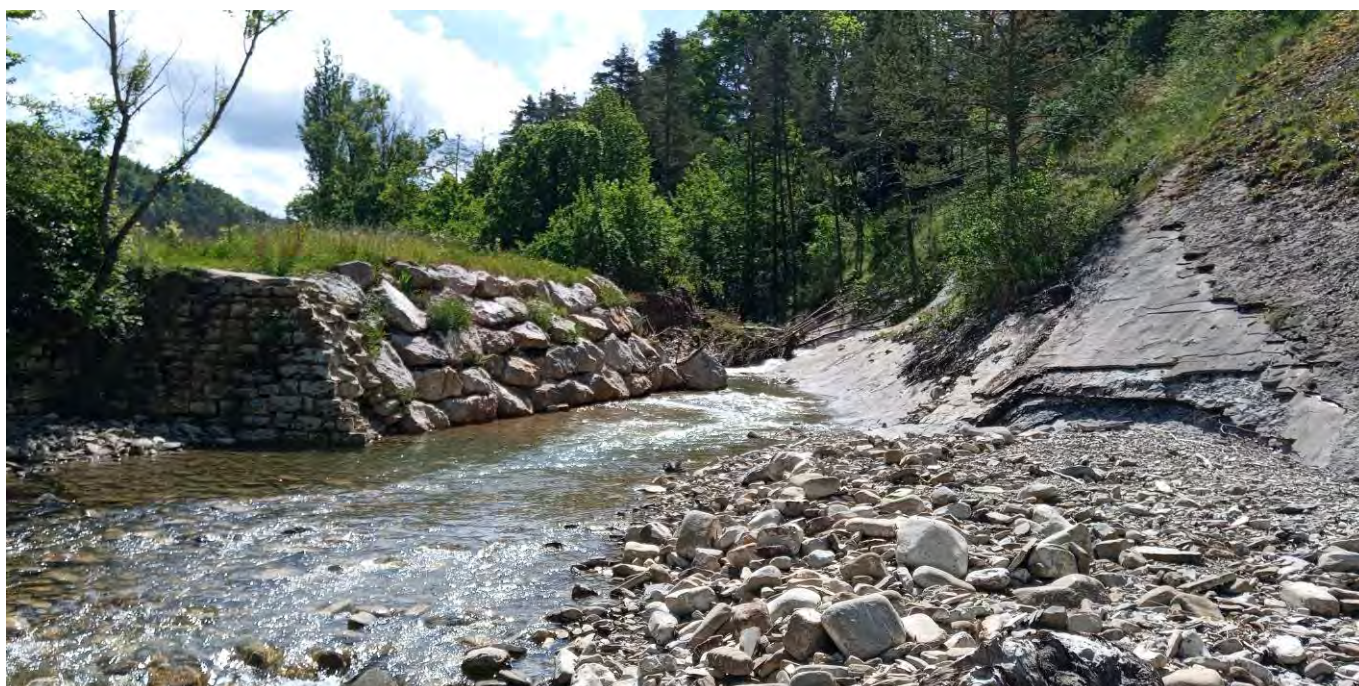
Río Xabros: aspecto hacia aguas arriba de la zona de obras
