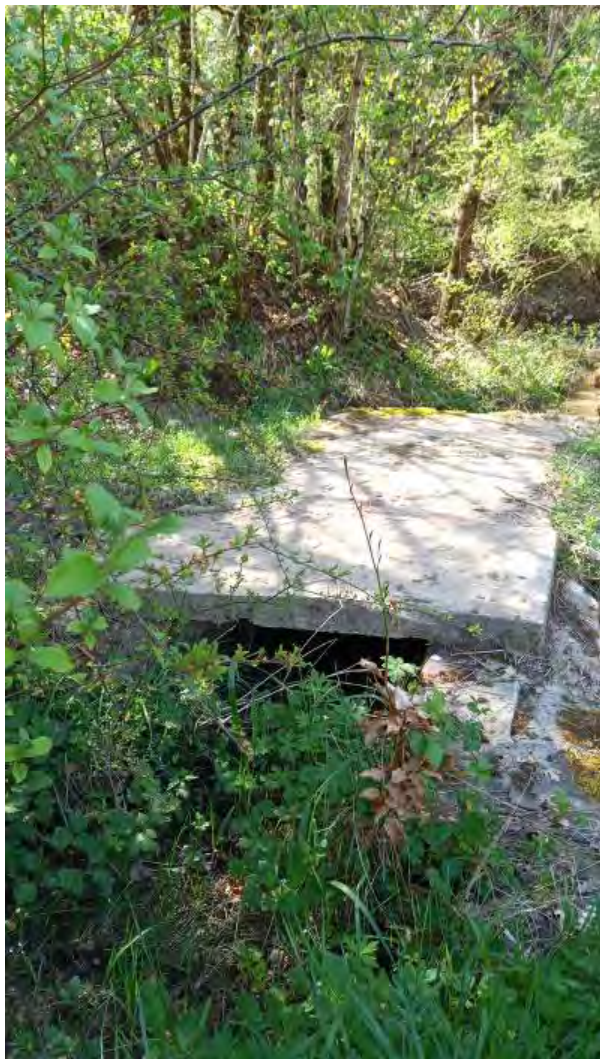
Bco. Las Huertas: imagen sección paso de agua existente a sustituir
