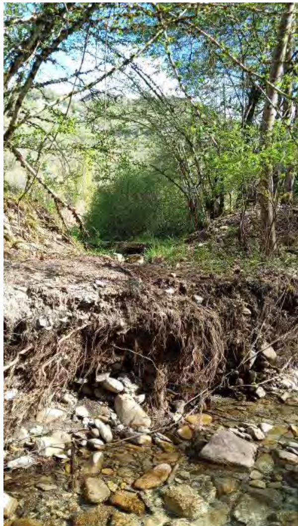
Bco. Las Huertas: aspecto desembocadura barranco a río Xabros a definir adecuadamente
