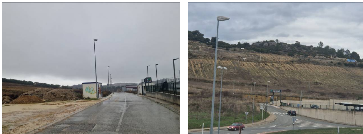
Columnas de acero galvanizado de 8 y 10 metros de altura
