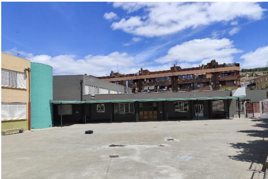
Fachada sureste, marquesina y guardería
