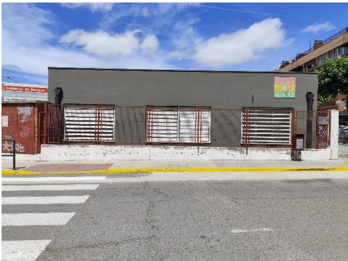
Fachada sureste guardería
