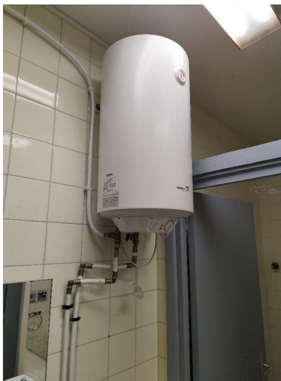
FOTO 18- Termo eléctrico para ACS sin protecciones y al alcance de los pequeños
