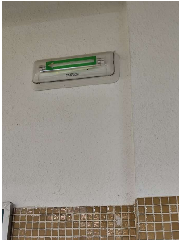
FOTO 50 y 51 – Luminarias de emergencia obsoletas y colocadas muy altas.
