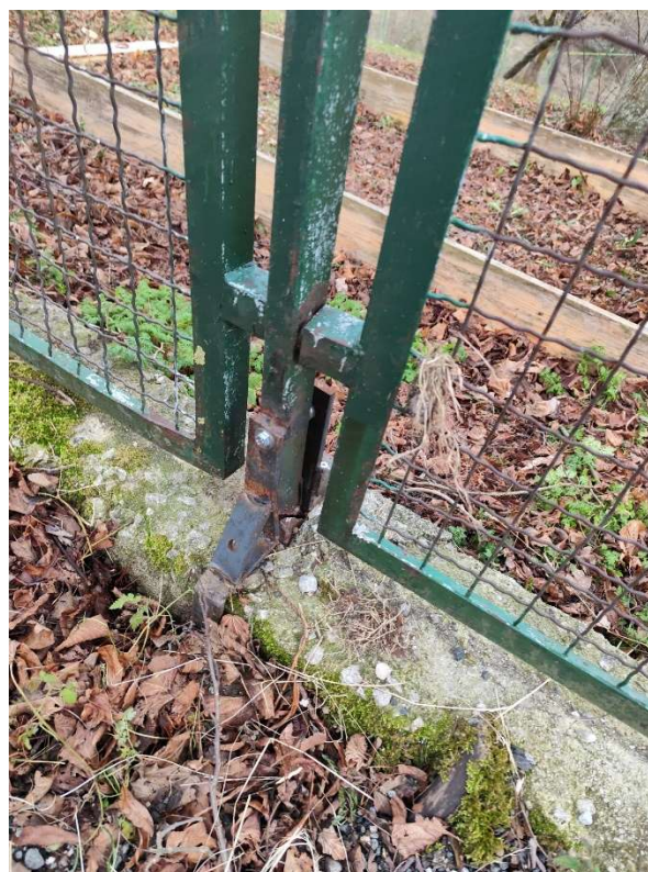
FOTOS 66 y 67 – Anclajes vallado perimetral A REPARAR O SUSTITUIR.
