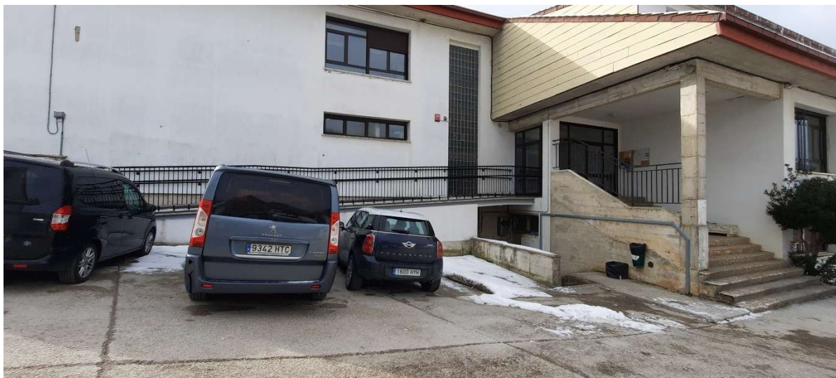
FOTO 02- Fachada edificio, rampa y entrada.
