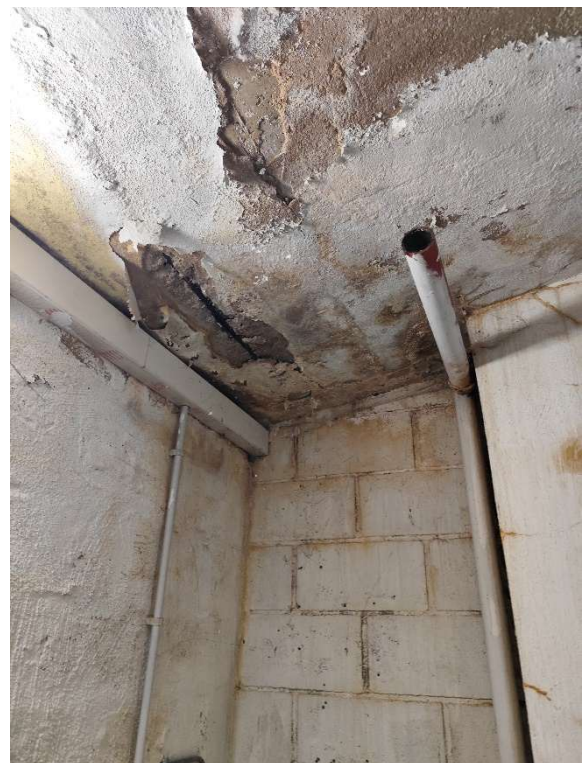
FOTO 40 y 41 – Desperfectos Sala de Calderas, muros sin impermeabilización.
