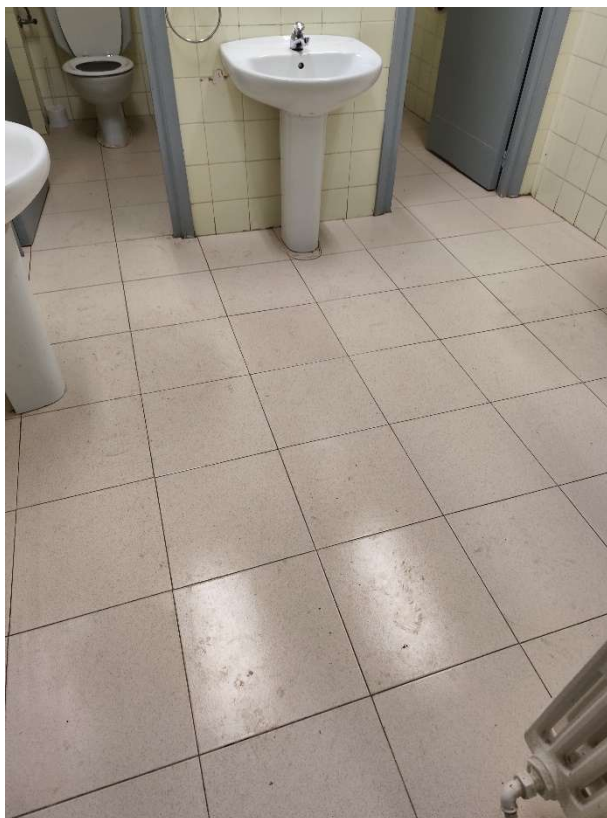
FOTO 16- Pavimentos a sustituir por un suelo antideslizante.
