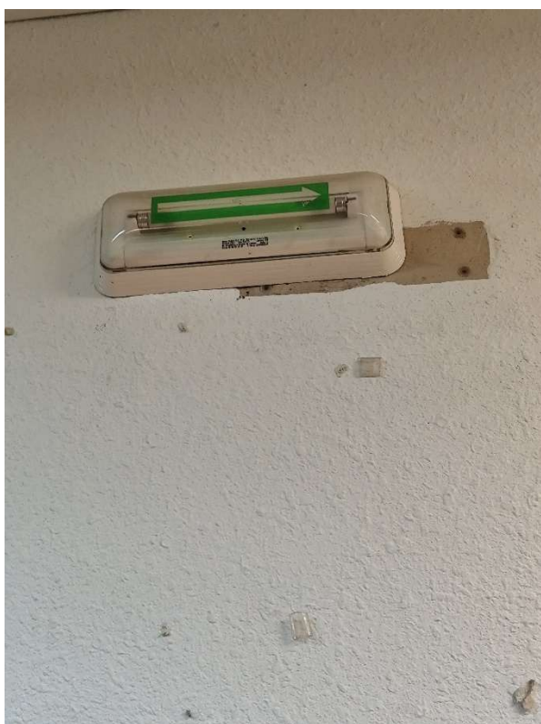
FOTO 50 y 51 – Luminarias de emergencia obsoletas y colocadas muy altas.
