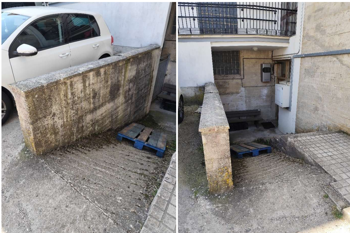
FOTOS 69 y 70 - Muros y rampas existentes a derribar.
