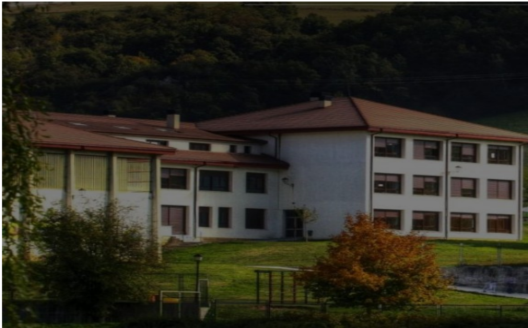
FOTO 01- Fachada edificio y anexo frontón (izda.).
