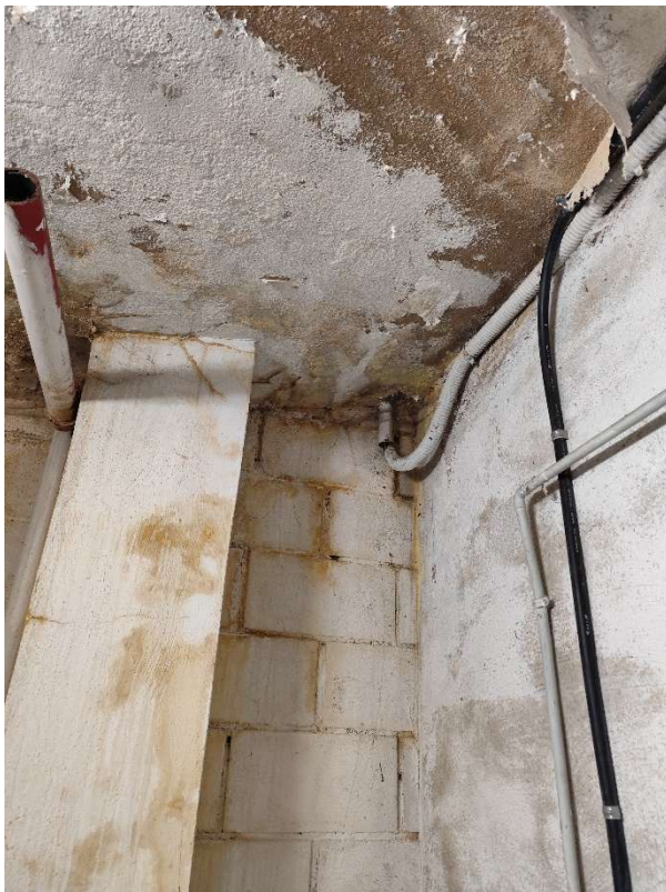
FOTO 40 y 41 – Desperfectos Sala de Calderas, muros sin impermeabilización.
