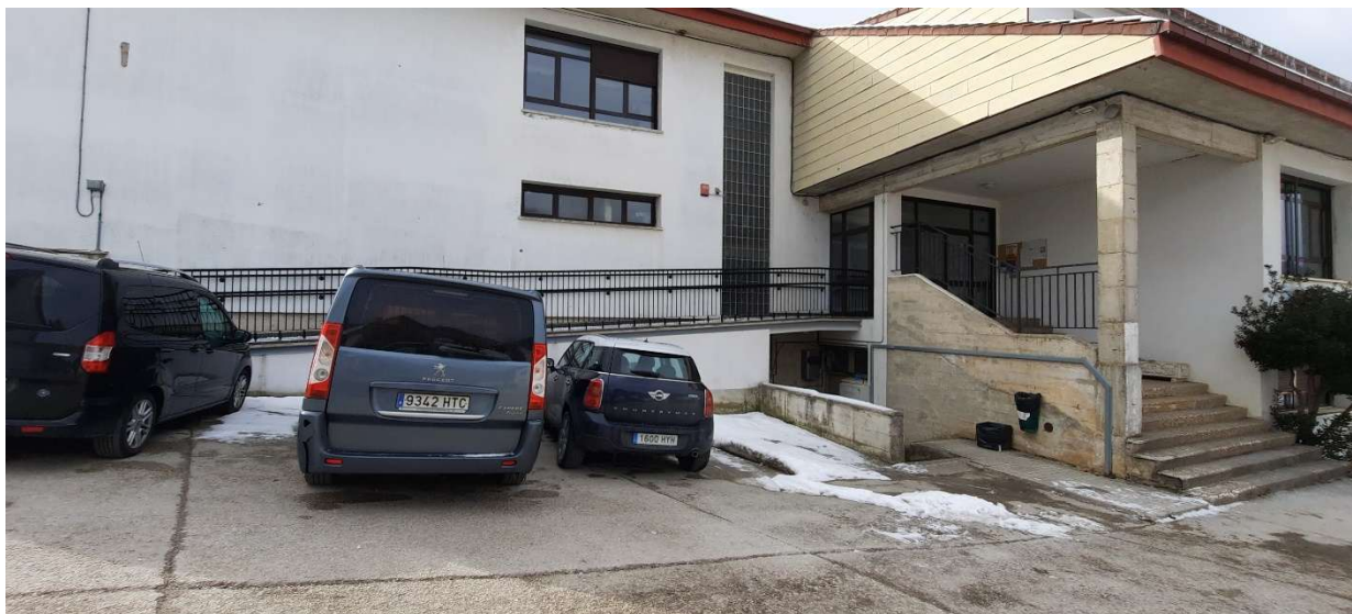
FOTO 32 – Acceso a edificio y detalles rampa accesibilidad.
