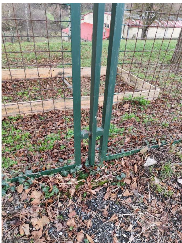
FOTOS 66 y 67 – Anclajes vallado perimetral A REPARAR O SUSTITUIR.
