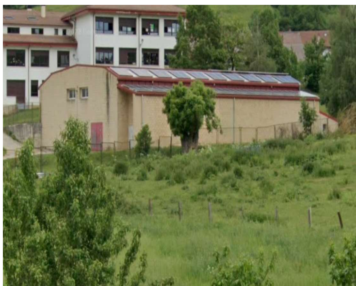
FOTO 03- Edificio Pista polideportiva y vestuarios.
