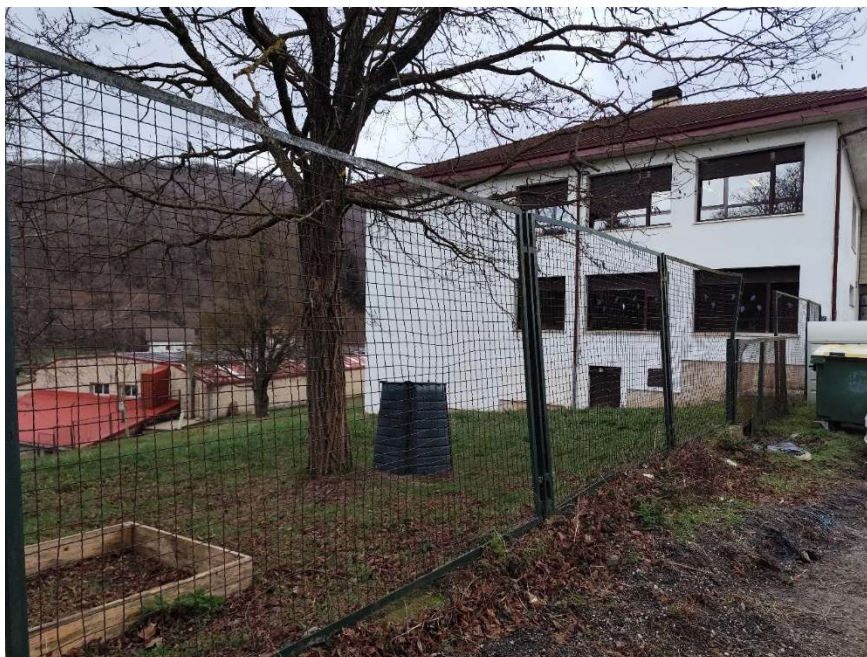
FOTOS 65 – Parcela y vallado perimetral A SUSTITUIR.
