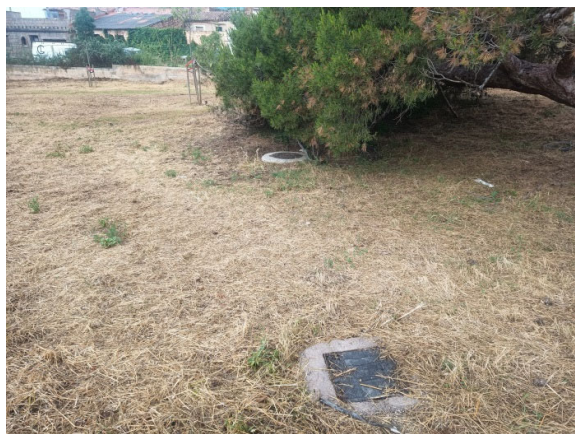
Imágenes de los registros de la acometida de abastecimiento FD250 hacia Guillermo de Tudela sobre general FD500.
