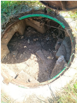
Imágenes de uno de los registros de pluviales que evacua hacia el canal de la imagen contigua, hacia la calle Padre Ubillos.
