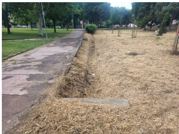
Imágenes de la evacuación de pluviales mediante canalización al aire, la cual se pretende modificar/demoler.
