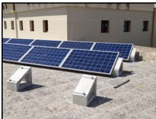
Ilustración 9: Soportes prefabricados de hormigón a 15º
