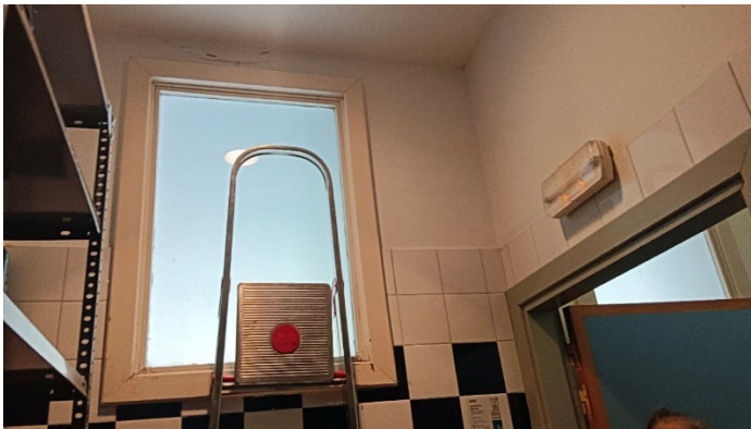
Ventana existente en almacén
