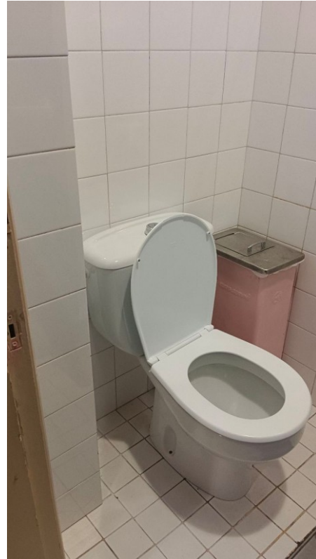
Baño de mujeres, una de las cabinas. Mochetas de bajante a desplzar.
