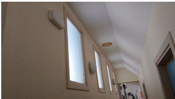
Falso techo a demoler y posterior ejecución repitiendo la forma actual
