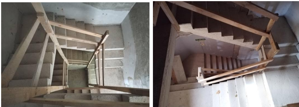
Izquierda, nueva escalera oeste. Derecha, escalera principal
