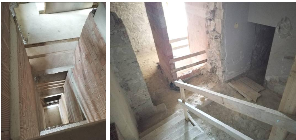
Izquierda, nuevo hueco de ascensor. Derecha, zona del núcleo de comunicación principal en planta baja
