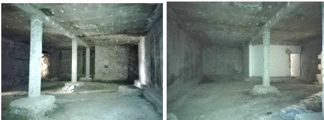
Planta baja, espacio semisótano junto a ala este
