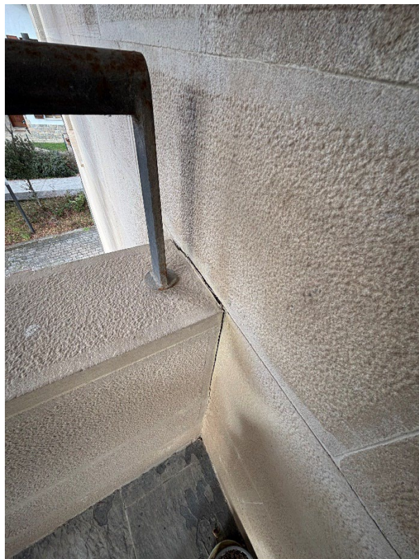
DESPEGUE DE PETO DE BALCÓN DE PLANTA PRIMERA EN FACHADA SUR
