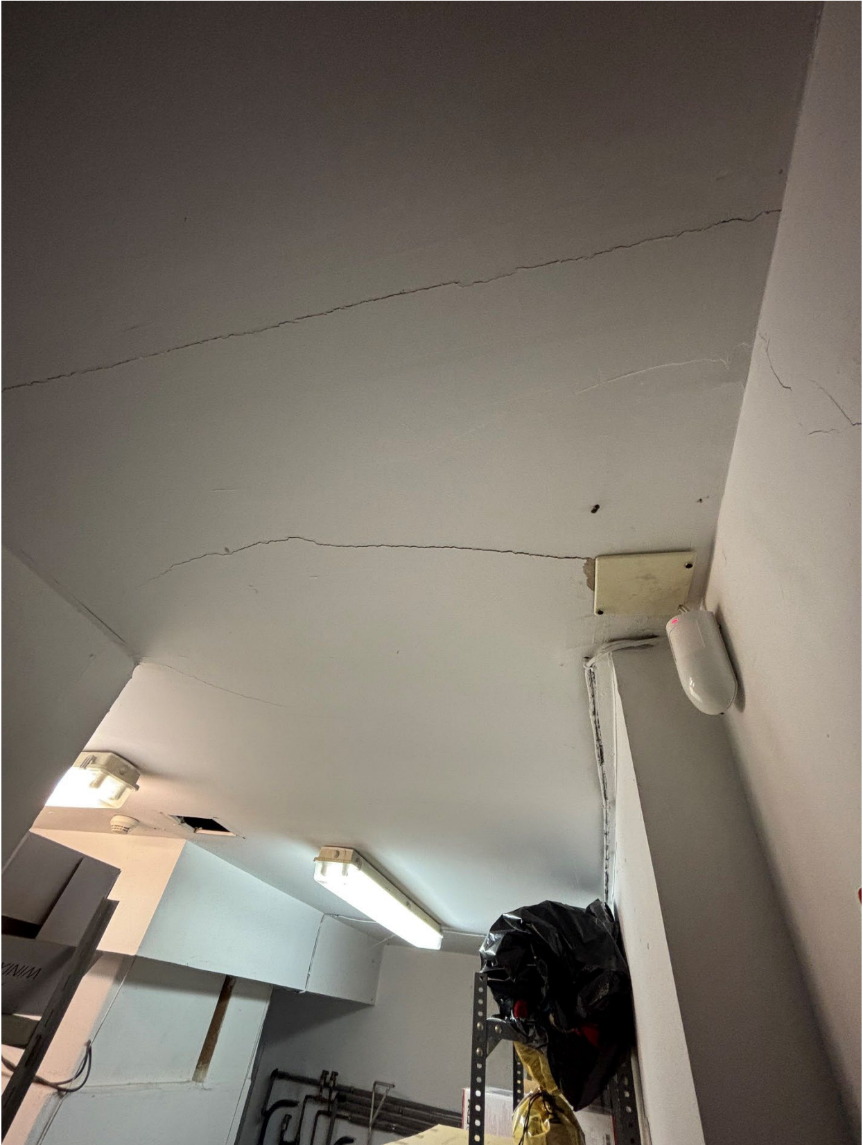
PLANTA BAJA FISURAS EN PAREDES Y TECHOS DE SALA DE CALDERAS (7)
