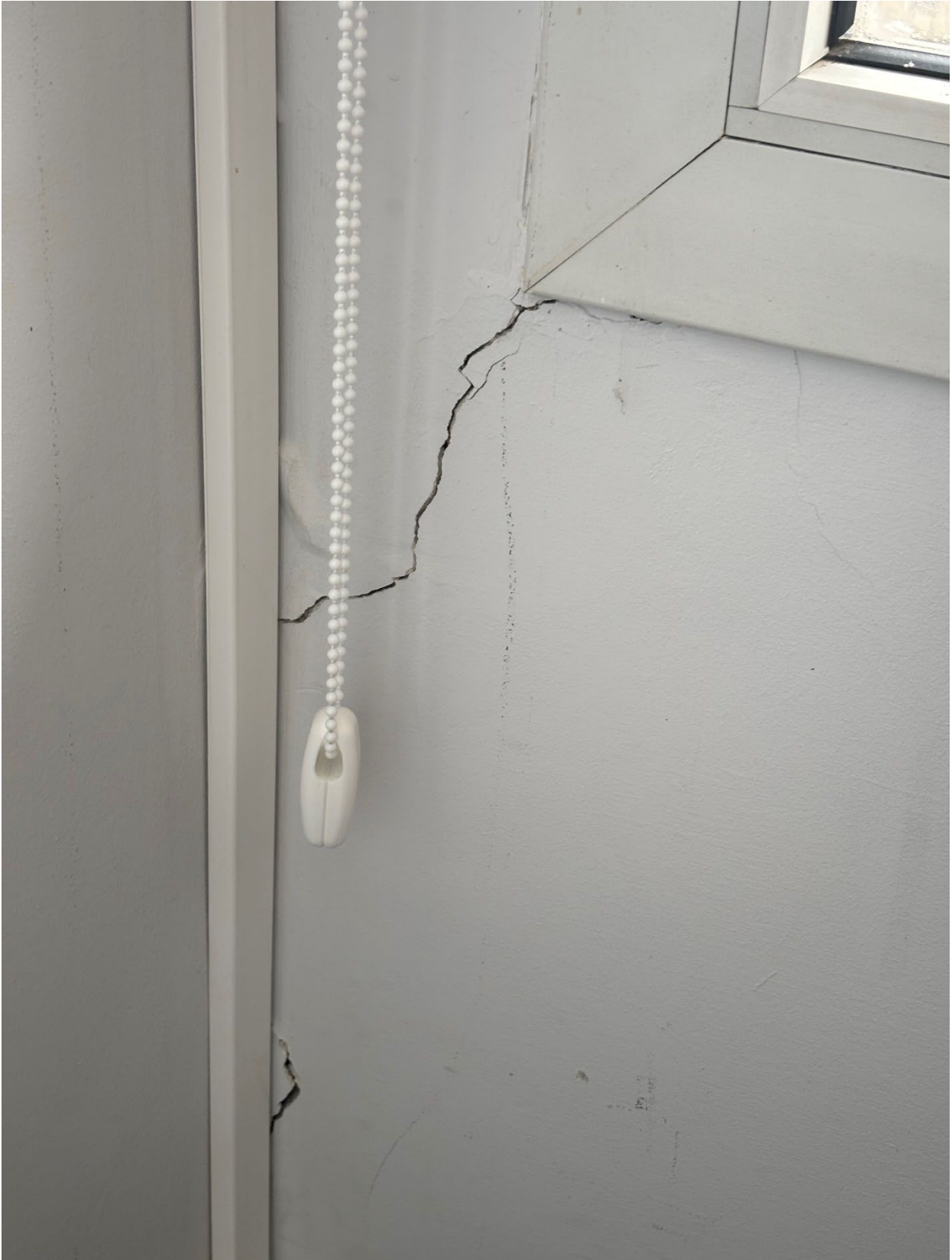
PLANTA PRIMERA FISURAS EN ESCUADRA ENTRE PAREDES ESTE Y SUR (15)
