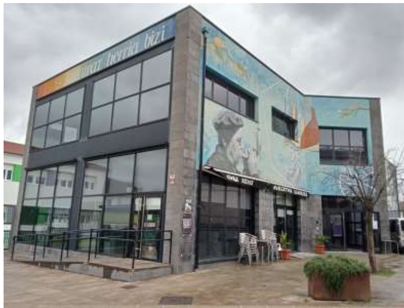
Vistas interior planta baja
