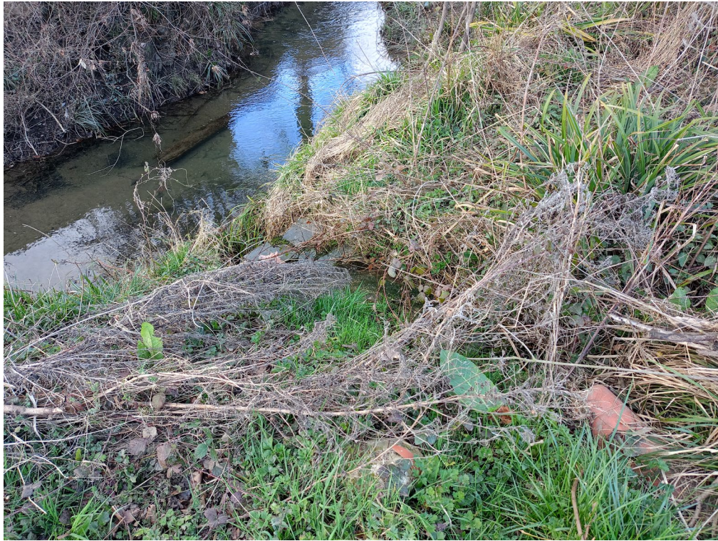
Salida bombeo a regata.
