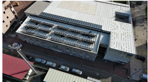
Fig. 2.3 Vista de la cubierta
