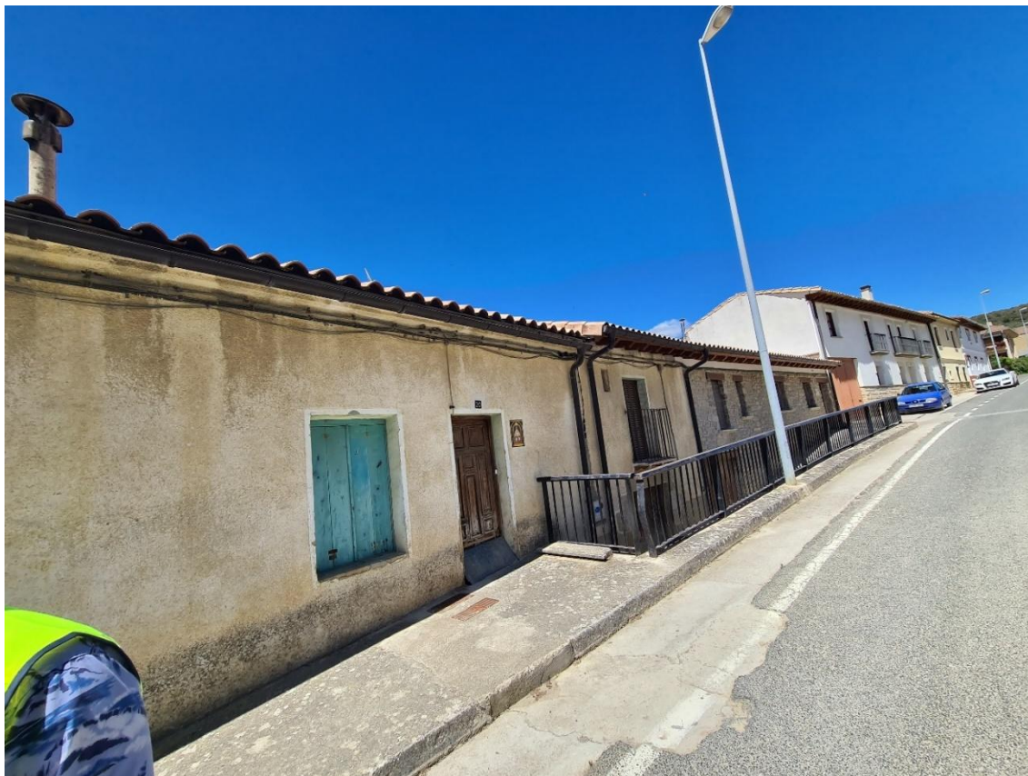
FOTOGRAFÍA 1: Portal donde comenzarán las obras de renovación de redes y pavimentación. Y muro de contención de la calzada que puede verse afectado por las obras.
