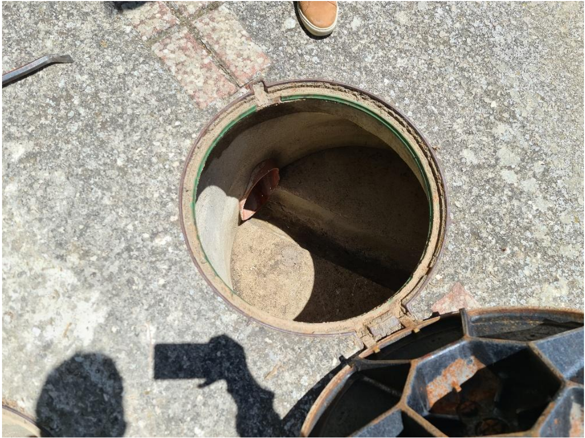
FOTOGRAFÍA 11: Pozo de registro de pluviales junto a portal 31 a entroncar y separar.
