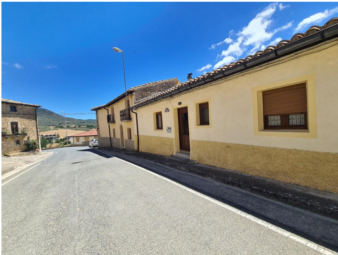
FOTOGRAFÍA 9: Aceras de dimensiones reducidas sin accesibilidad.
