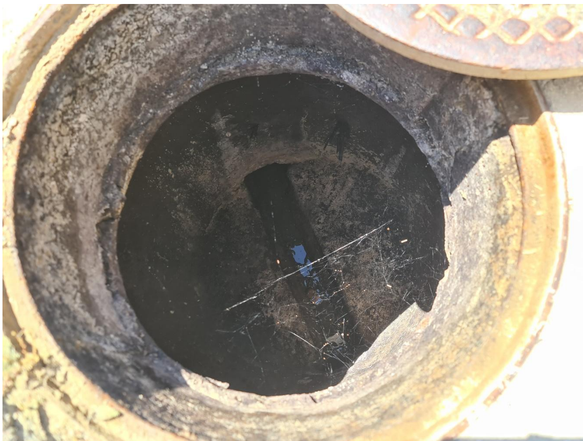
FOTOGRAFÍA 4: Detalle interior pozo.
