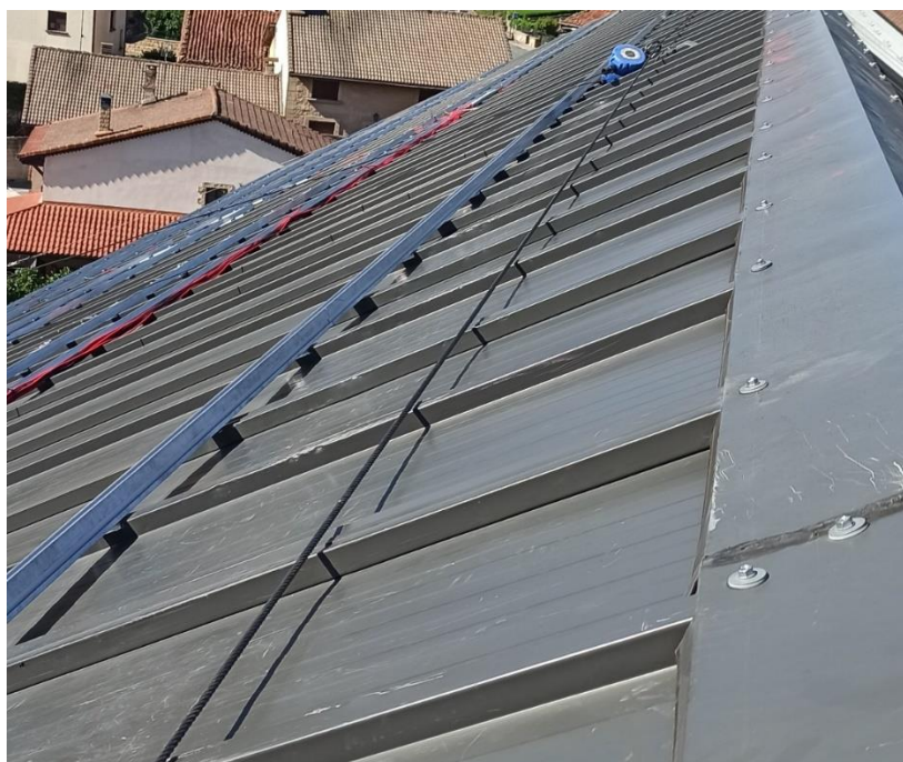
Imagen 10: Perfiles instalados sobre grecas.
