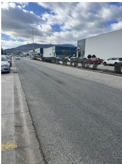
FOTO 1. Firme rehabilitado desde paso de peatones hasta Gurpea
