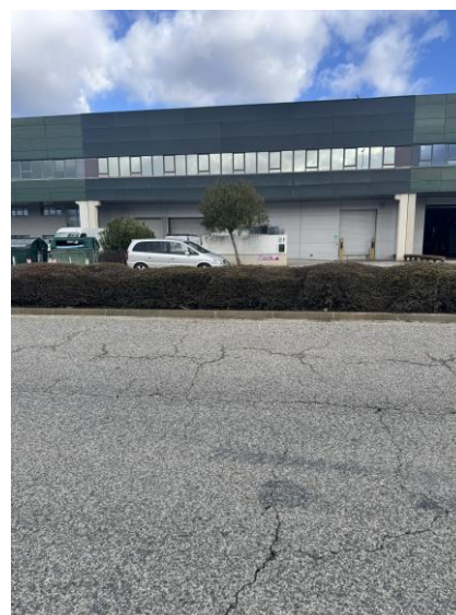
FOTO 3. Firme en frente de la nave nº 16.
