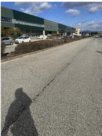
FOTO 4. Firme delante de INM Ingenieros Navarra Mecánica.
