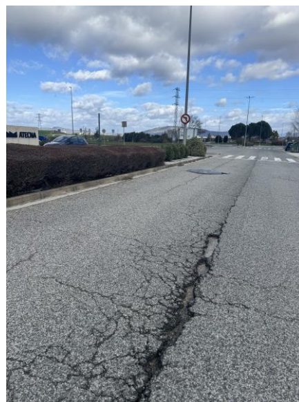
FOTO 15. Firme delante de Atecna
