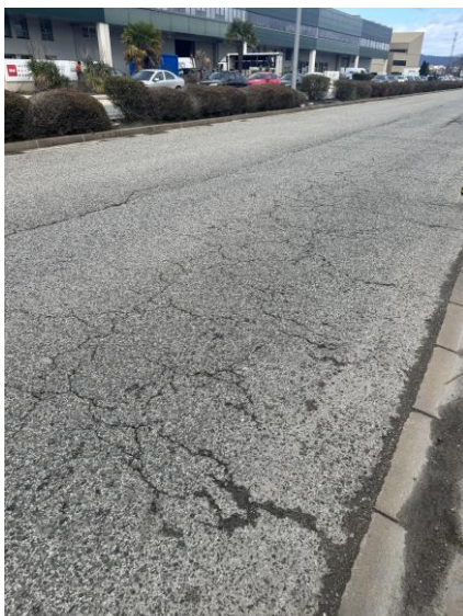
FOTO 5. Firme delante de INM Ingenieros Navarra Mecánica.
