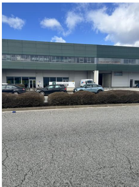
FOTO 10. Firme delante de nave nº 6
