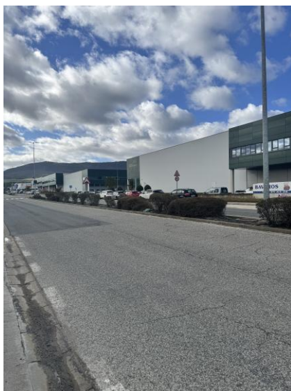
FOTO 2. Firme rehabilitado desde paso de peatones hasta Gurpea
