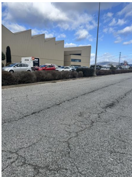
FOTO 13. Firme delante de Atecna
