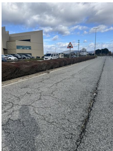
FOTO 14. Firme delante de Atecna
