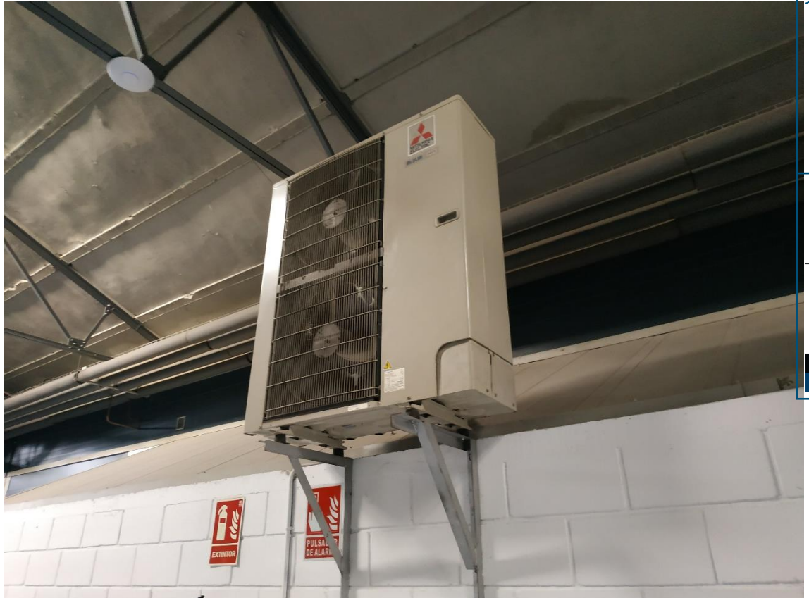
Reubicación de equipos de climatización en CEIN- ANEXO
