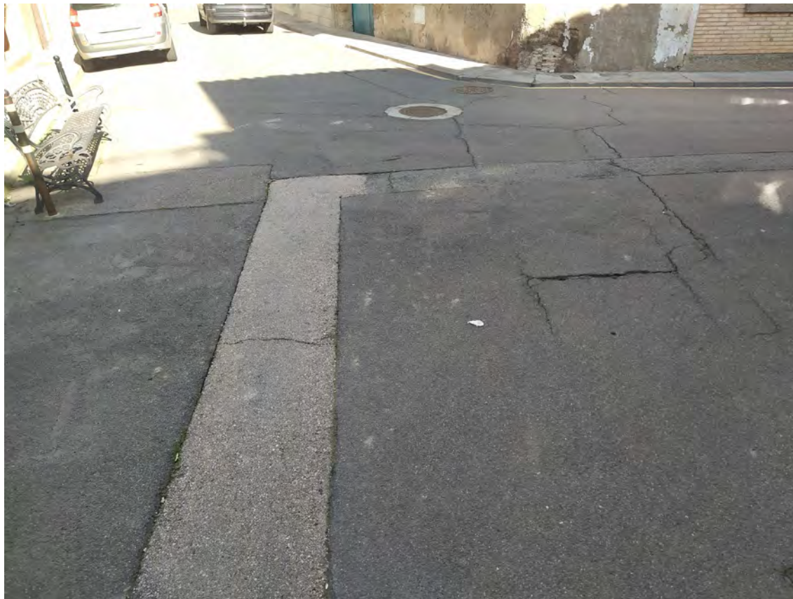
Vista zona central callejón, en zona final de la calle
