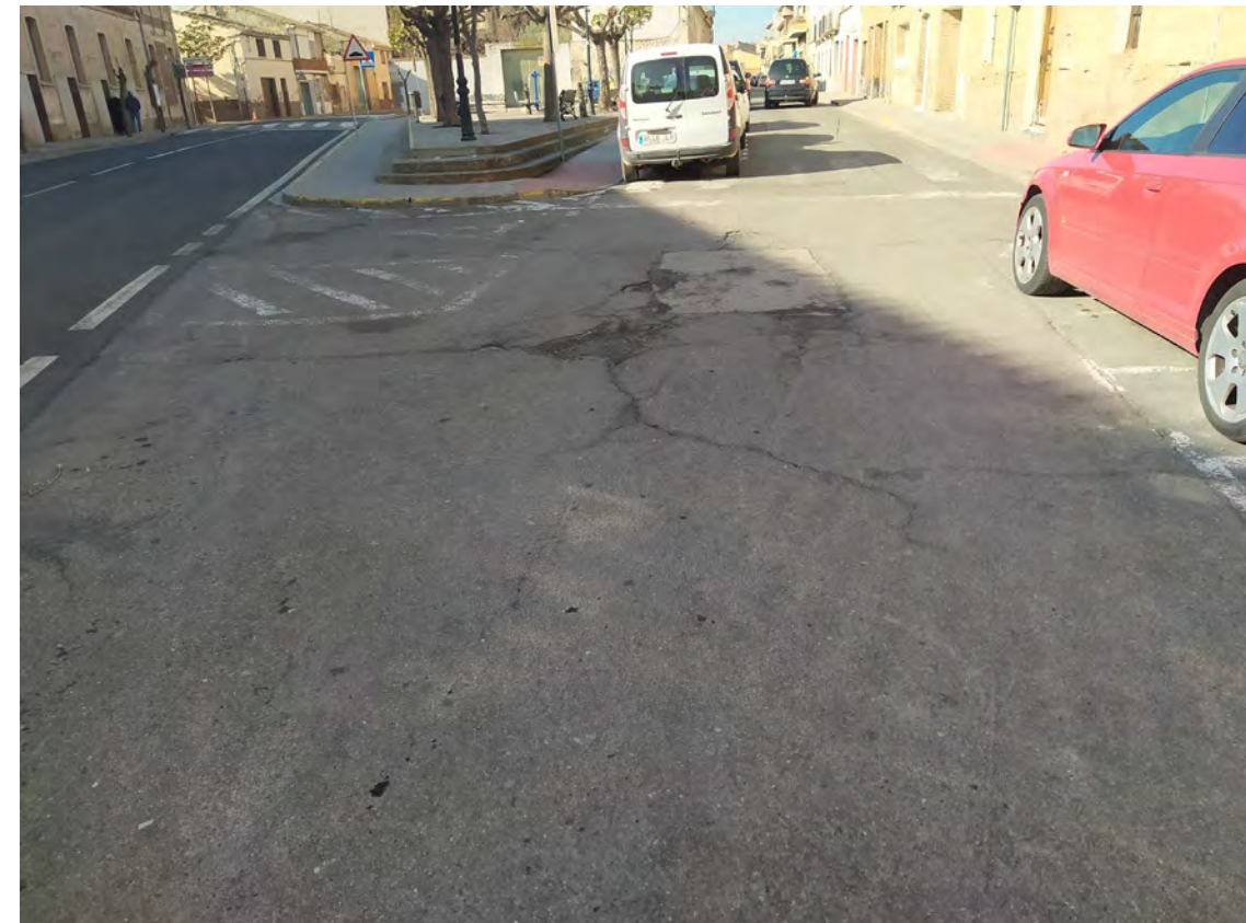
Vista inicio calle, intersección con calle Mayor
