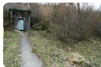
Fig 3.4.2 Frente y MD depósito.
