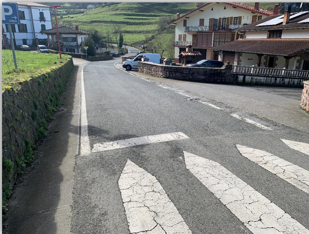
Fotografía 7 – Entrada a la urbanización, construcción de nudo 2.
