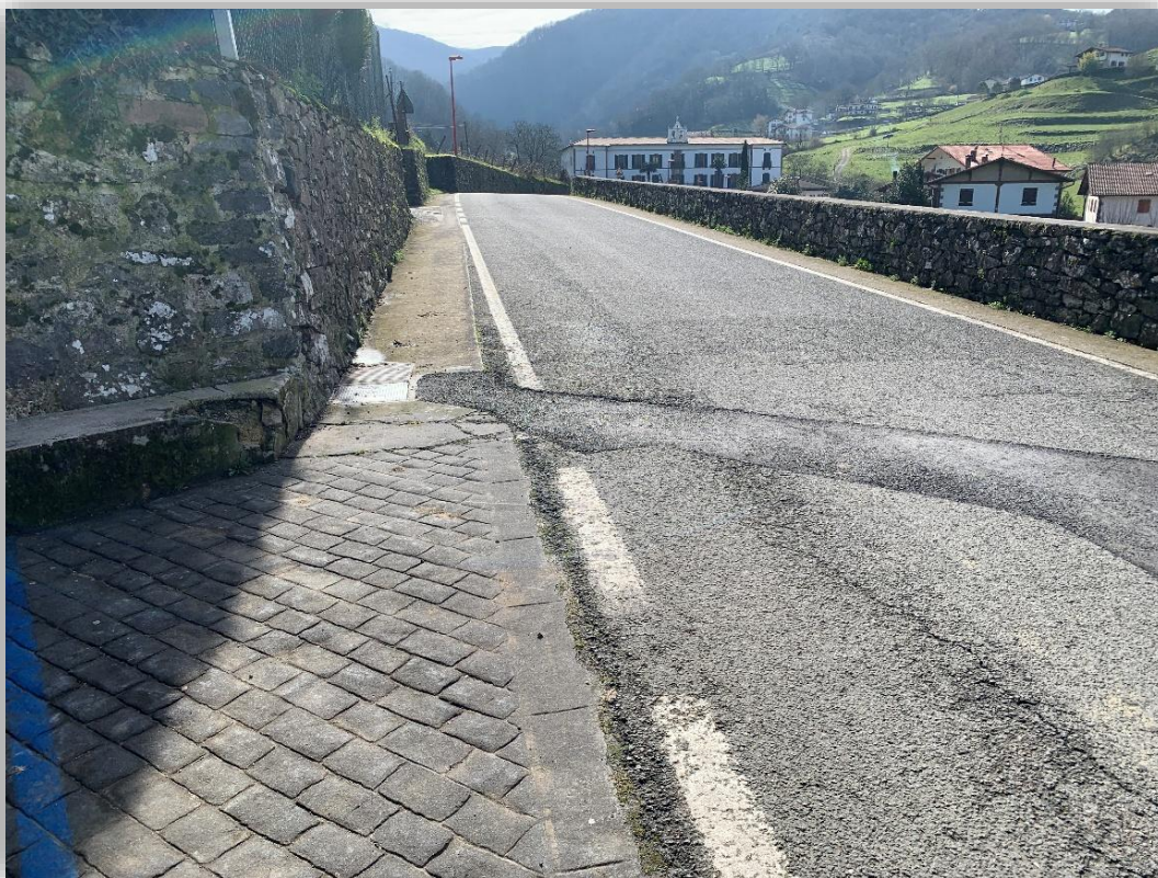
Fotografía 3 – Detalle de uno de los cruces con pluviales.
