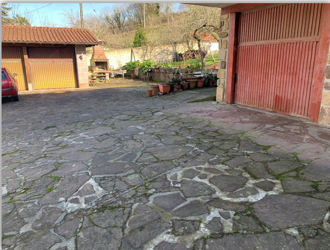
Fotografía 14 – Zona de losa acometidas.
