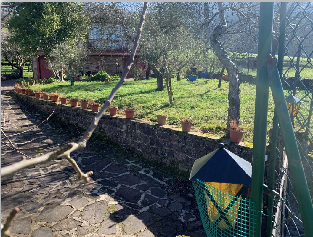
Fotografía 13 – Zanja por jardín para acometidas.
