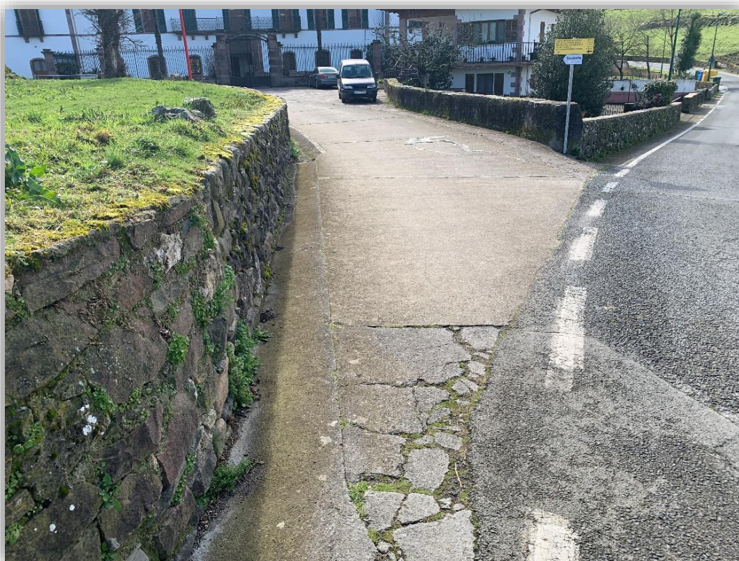
Fotografía 8 – Entrada a calle para conexión con existente, acometida convento.
