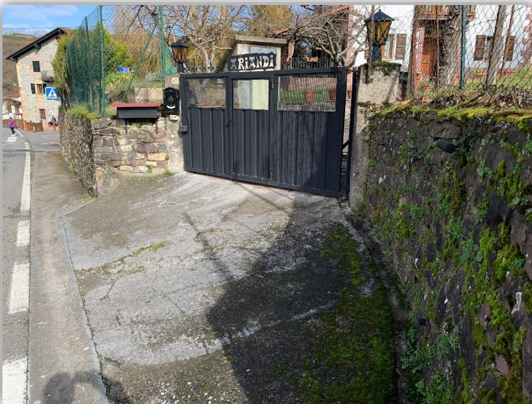
Fotografía 4 –Entrada de acometidas, cruce bajo muro.
