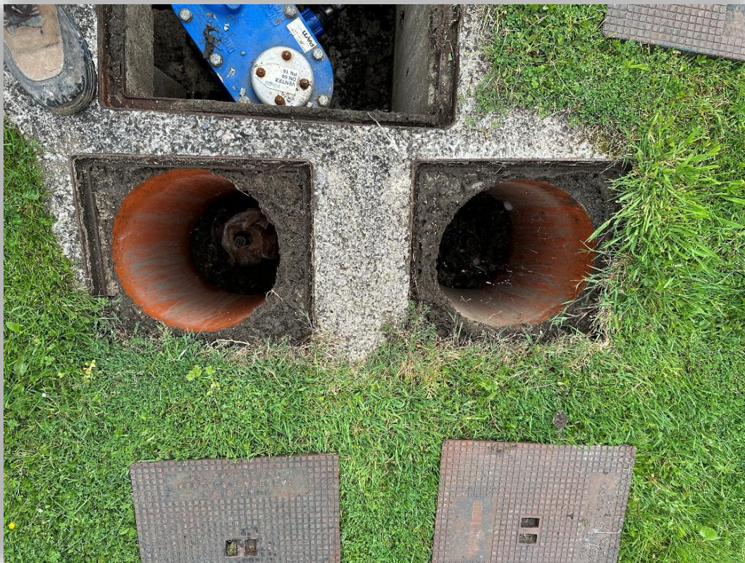
Fotografía 11 – Conexión acometida zona del frontón.
