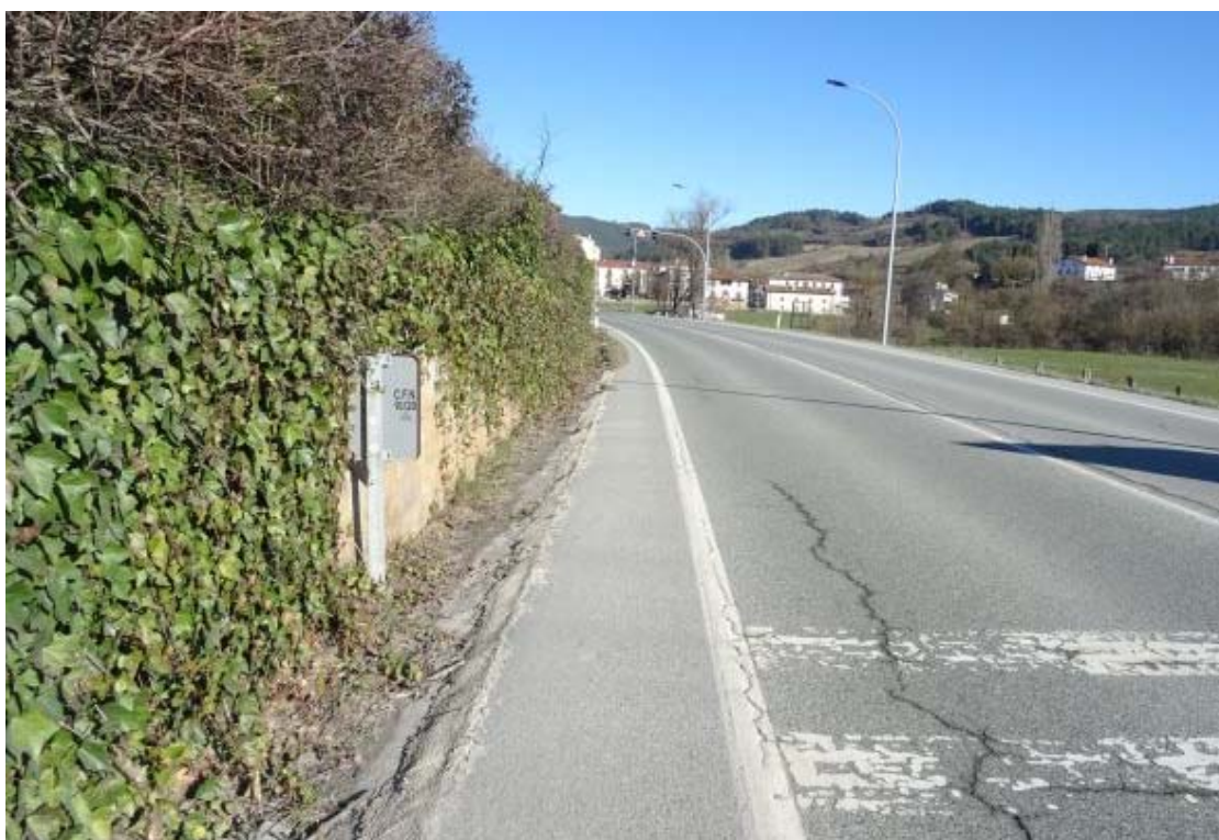
Cuneta hormigonada contra muro de contención.
