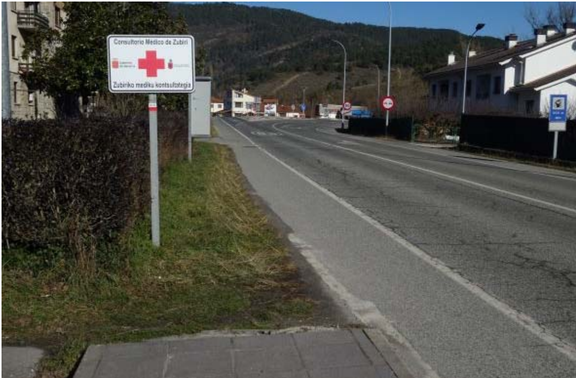
Final acera existente
