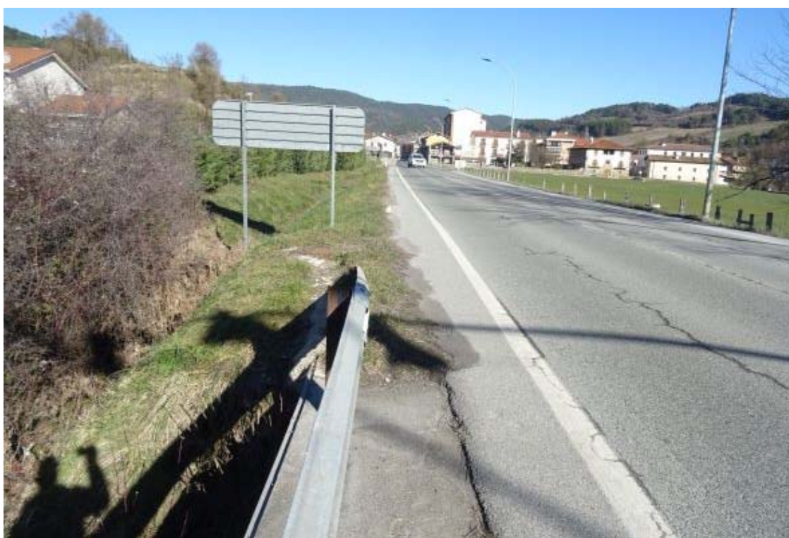
Puente sobre regata Leranotz.
