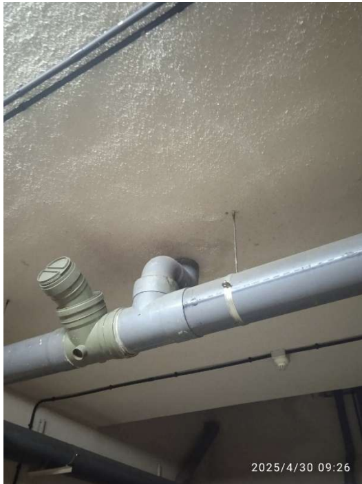
Antes de prueba de agua
