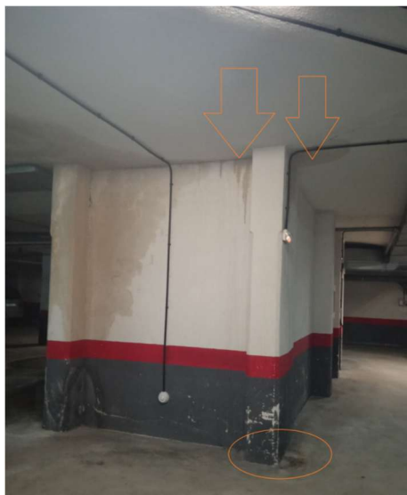
Filtraciones en garaje coincidente con zona encharcada plaza
