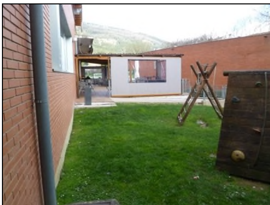
Vista desde el oeste
