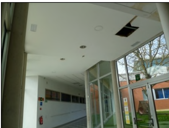
Cruce de vestuarios a pasillo
