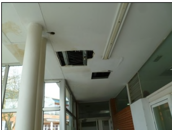
Falso techo entre vestuarios
