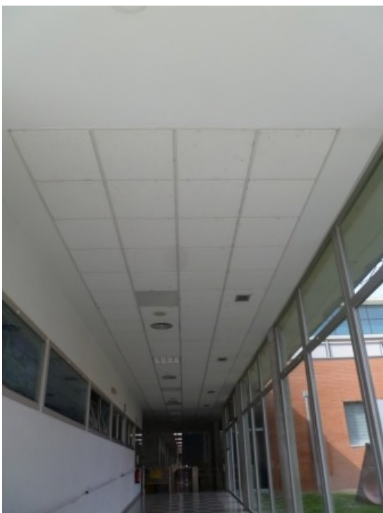
Pasillo entre entrada y vestuarios
