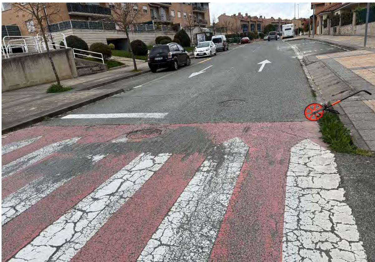
Seguidamente encontramos las dos primeras paradas de autobús, a derecha e izquierda. Se observa una reparación del pavimento a la izquierda.
