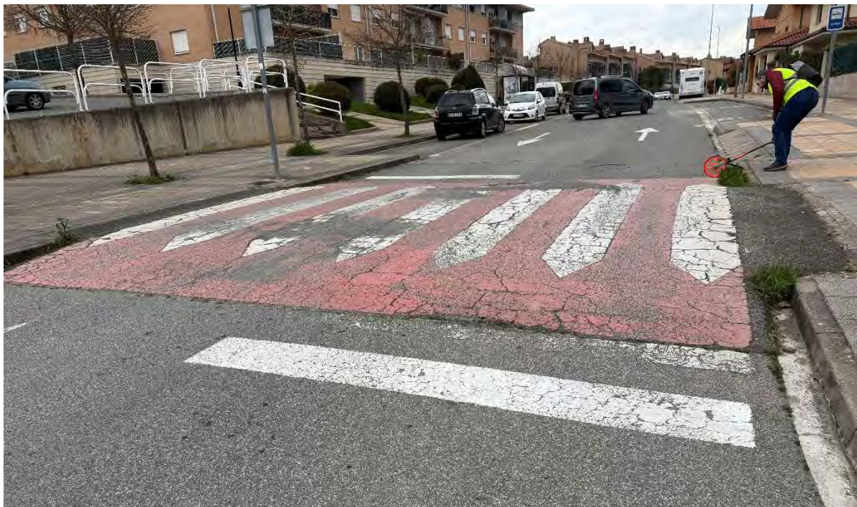
PK 52,90. Primer paso de peatones elevado.
