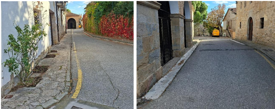
Figura 9 Estado actual - Calle San Andrés (derecha) e Iglesia de San Andrés (izquierda)
