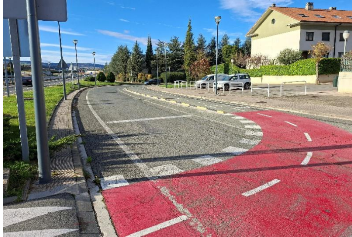
Figura 3 Estado actual – zona próxima a la glorieta de la A-12
