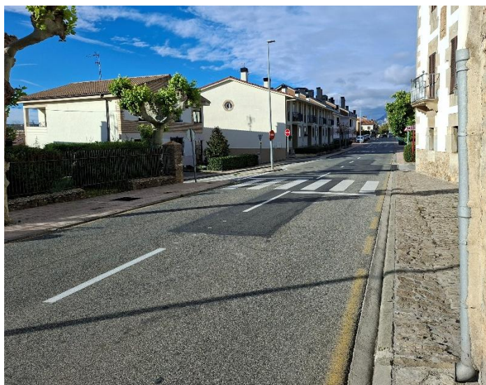
Figura 7 Estado actual - Avenida Belascoain
