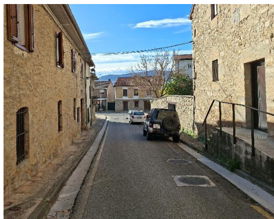
Figura 10 Estado actual - Calle San Isidro
