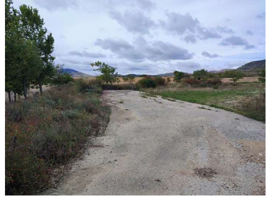
10.- Vial interior actual
