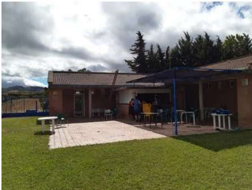
Edificio de Vestuarios
