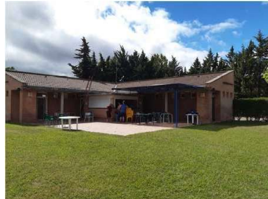
Edificio de Vestuarios
